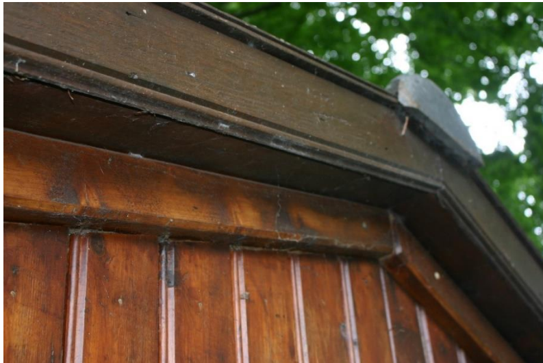
Figuur 4.5.3. De nokken van het opslagschuurtje zijn niet toegankelijk en het dak, de windveer en de kopgevels sluiten nauw op elkaar aan.
