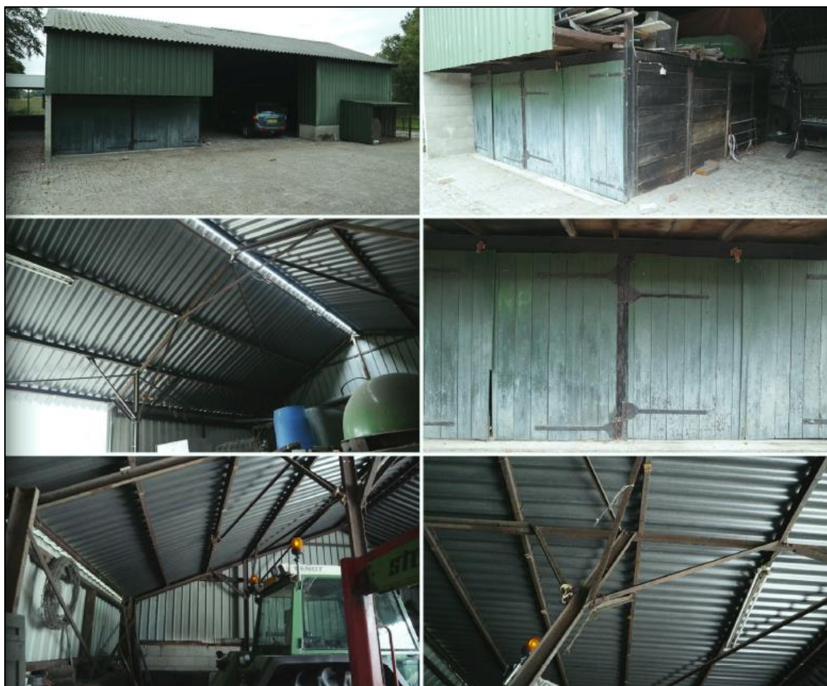
Figuur 5: Fotoweergave (tabak)schuur (Bron: Architectenbureau Van Der Geld)
