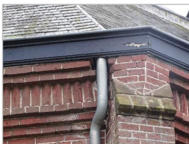
Foto 15: Openingen bij aansluiting regenpijp.
