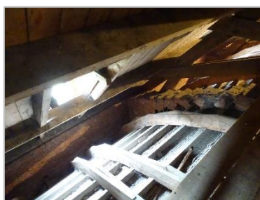
Foto 27: Zolderruimte met dakkapel (glazen raam).
