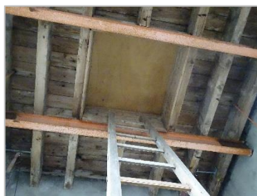
Foto 29: Toegang tot galmgaten toren.
