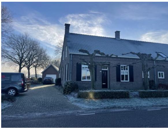
Voorgevel woonboerderij met leilindes en buxus hagen (boerderij wordt niet gesloopt).
