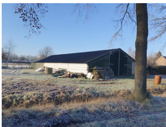
Loods: metalen wanden en dakbedekking (loods wordt gesloopt).
