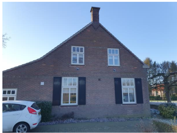
Zijgevel: strakke gevels gevelpannen met cement aangesmeerd. Nieuw dak met vogelschroot. Schoorstenen afgedicht met gaas.
