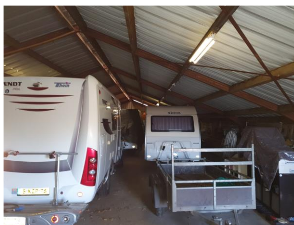
Interieur loods: geen isolatie (niet vorstvrij).
