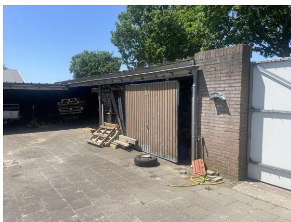
Te slopen bedrijfsbebouwing.
