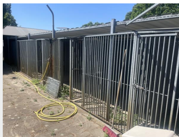
De lage hondenverblijven op de projectlocatie hebben een metalen damwand dakbedekking en zijn aan de voorzijde open.
