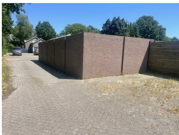
Te slopen schansmuur.
