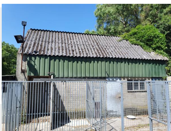
Te slopen bedrijfsbebouwing en buitenverblijven. Golfplaten dakbedekking.
