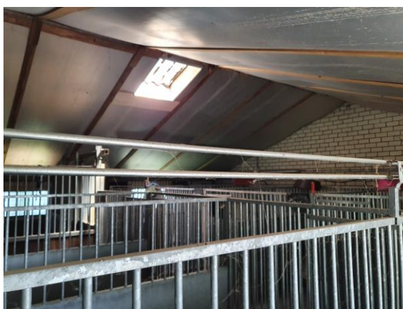
Interieur van een hondenverblijf. Golfplaten dakbedekking geïsoleerd met dupanel.
