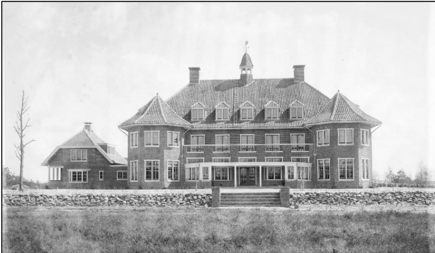
Stapelstenen muurtjes als overgang tussen hoog en laag bij Rustoord (Bron: NA, nr. NL-HaNA_2.24.06.02_0_253-7289)
