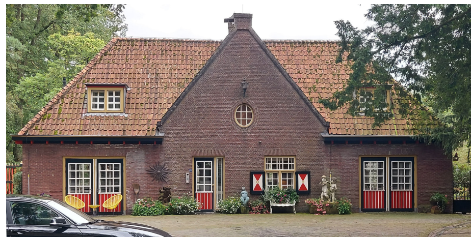
Foto van de kokswoning. Van oorsprong is dit geen dienstwoning maar ketelhuis wat later is verbouwd tot woning.
