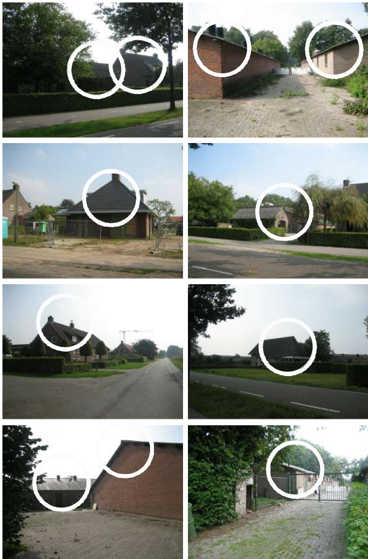
BESTAANDE PANNENDAKEN HAKVOORTSEWEG
