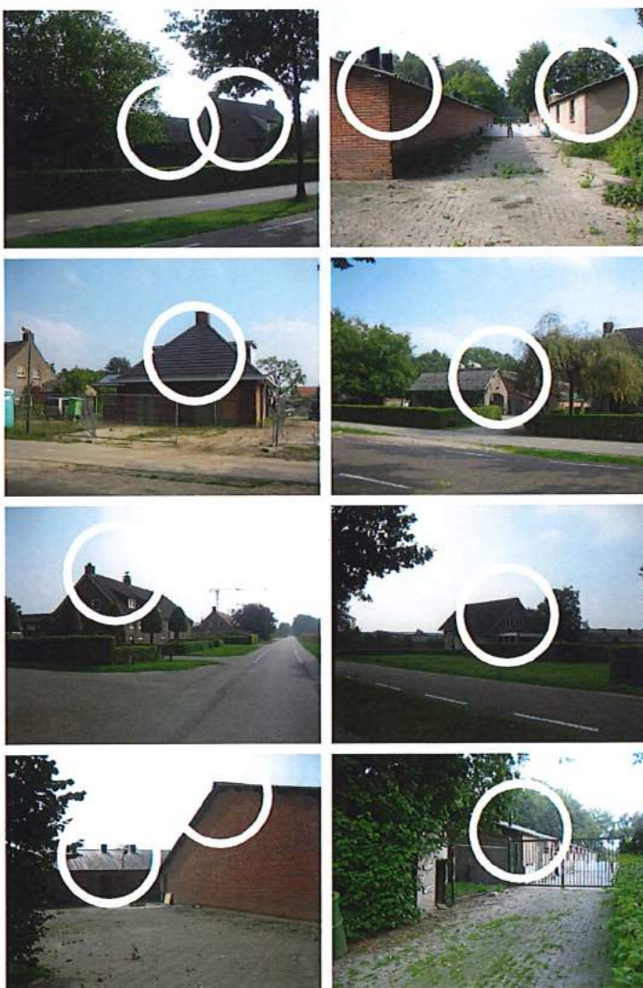
BESTAANDE PANNENDAKEN HAKVOORTSEWEG
