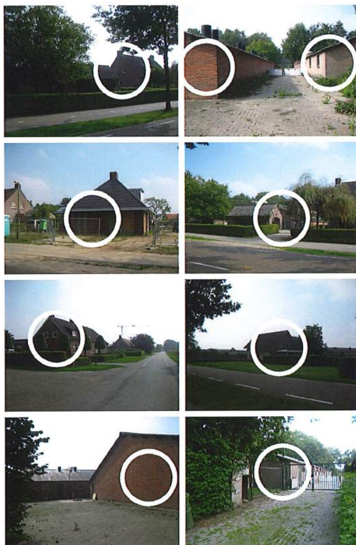
BESTAAND METSELWERK HAKVOORTSEWEG
