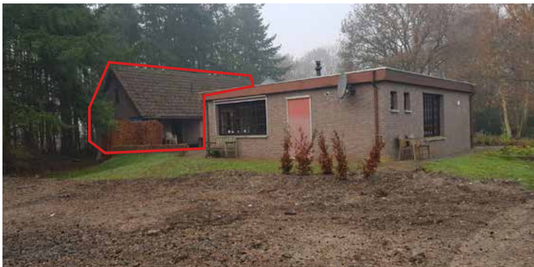
Overzicht, woning (vooraan) en schuur (achter)
