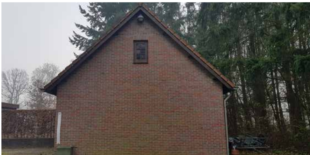
Schuur met pannendak.
