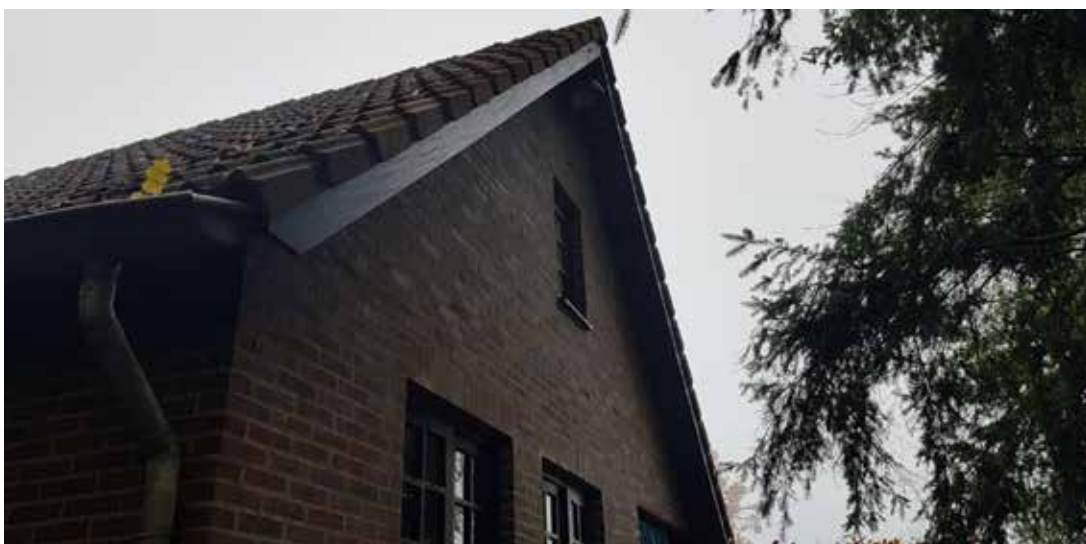
Schuur met pannendak.
