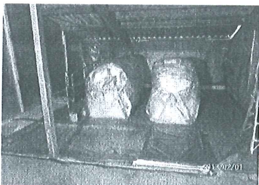
DUBBELVERPAKT ASBESTHOUDEND AFVAL
