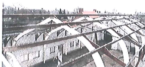
foto 8: Gолplaten verwijderd. Stal 2.
