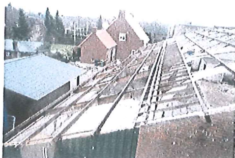
foto 1: Gолplaten verwijderd. Stal 2.
