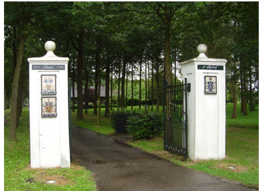
Figuur 38: referentie toegangspoort
