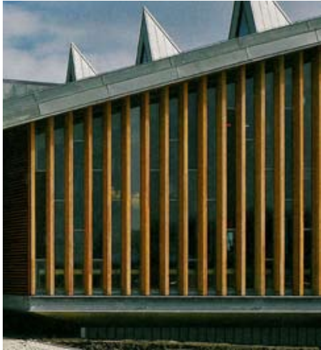
Uitvoering gevels met extra diepe verticale profilering
