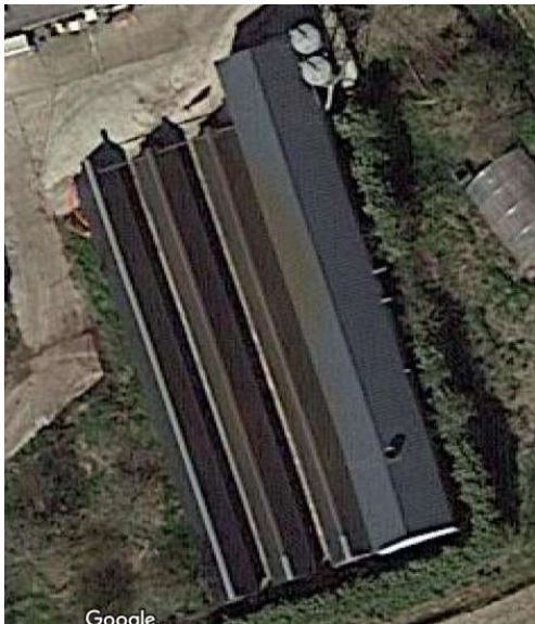
Figuur 6: De konijnensheds en konijnenstal die zullen worden afgebroken
