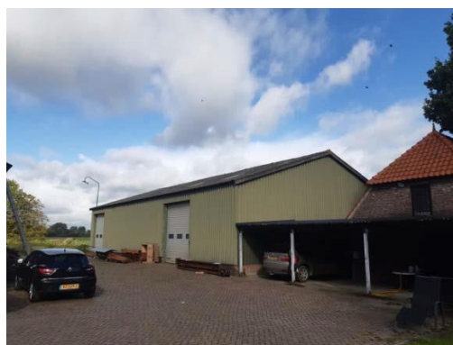
Foto 2 - Brontype - 01: Golfplaat schuur 1
