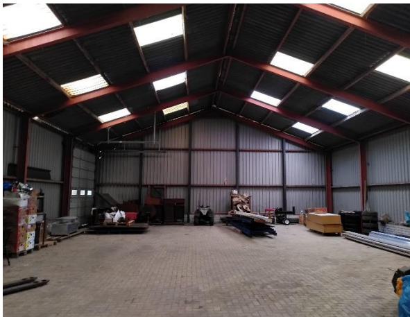
Binnenzijde nieuwe werkloods
