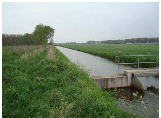
Foto 8. Dijk ten zuiden van het bos met te verwijderen gasleiding.
