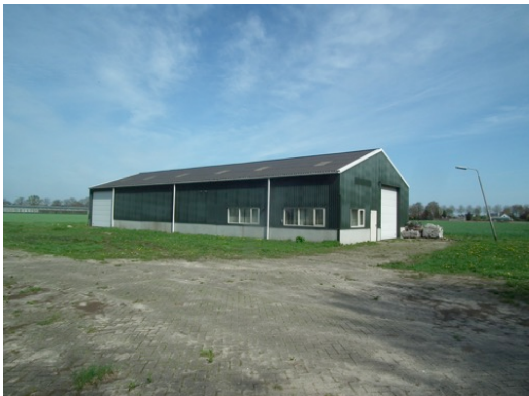
Figuur 4 Het oude bedrijfspan dat gesloopt gaat worden om plaats te maken voor een kas bevindt zich naast het maaisveld.
