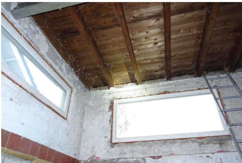
Afbeelding 6: Oud slachthuis met een steens gemetselde muur (geen spouwmuur) en een dak zonder tussenruimte welke mogelijk geschikt zou kunnen zijn voor vleermuizen. Bron: R.J.L. Bijvelds 09-12-2020
