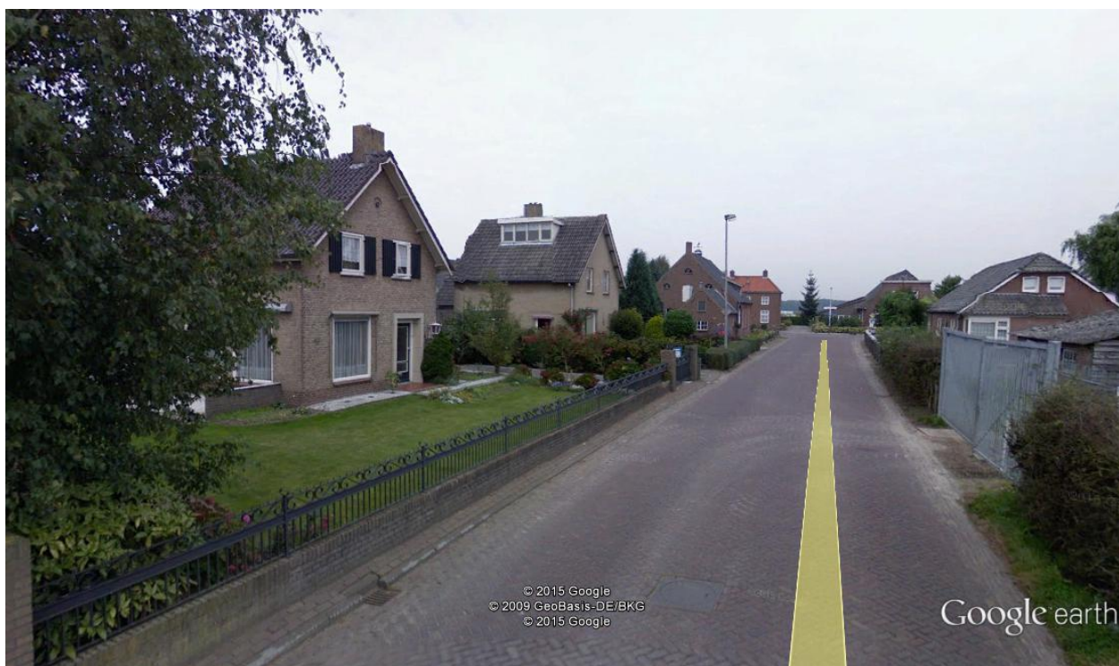
Fig. 8 Gerealiseerde woningbouw Elshoutseweg 4 en 2.
