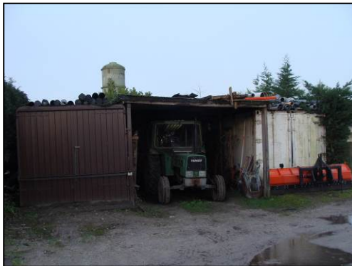
Foto 9. Containers en opslag
