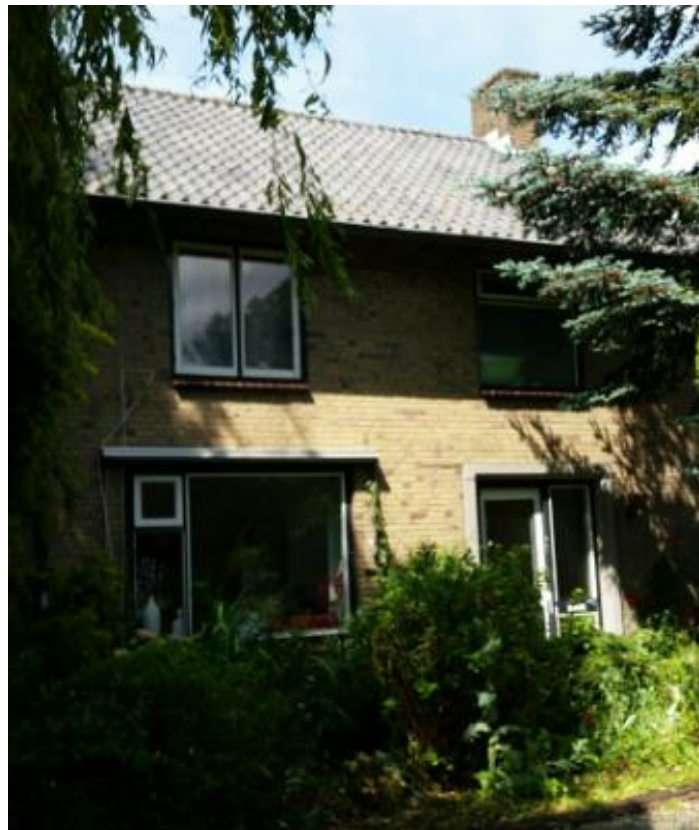
Fig. 8 Bestaand pand Laagstraat 6.
