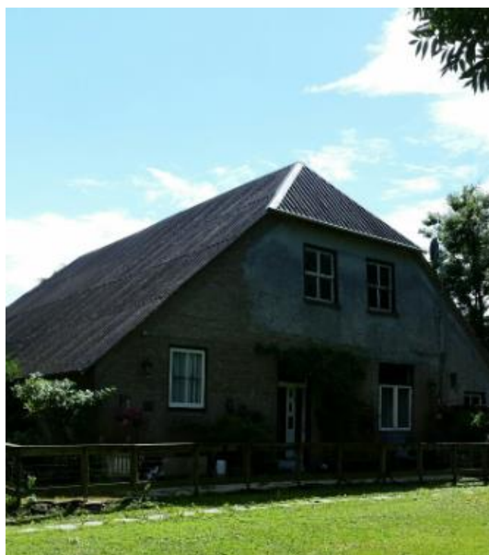
Fig. 10 Achtergevel bestaand voormalig agrarisch bedrijfsgebouw
