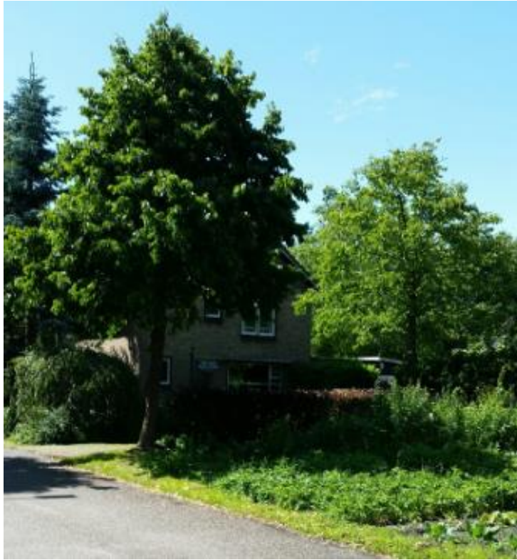
Fig 7 Bestaand pand Laagstraat 4.
