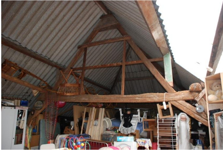
Afbeelding 18; het dekbalkjuk
