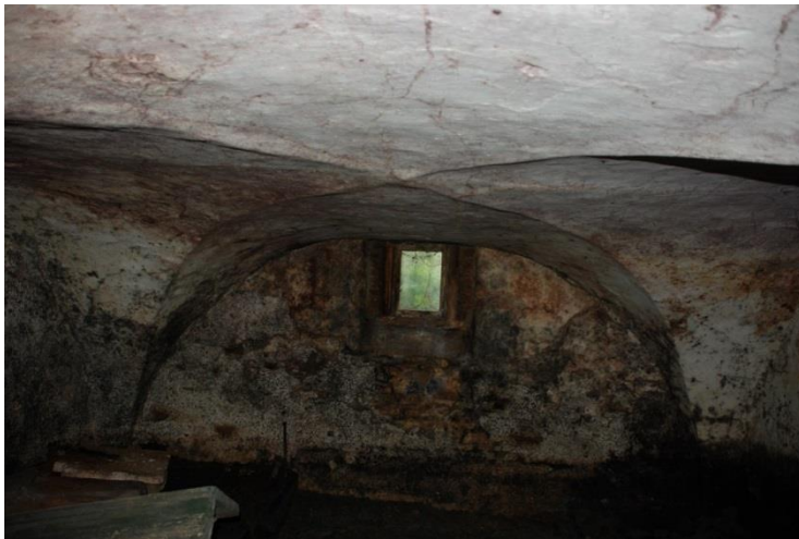
Afbeelding 6; ruimte 1, de kelder
