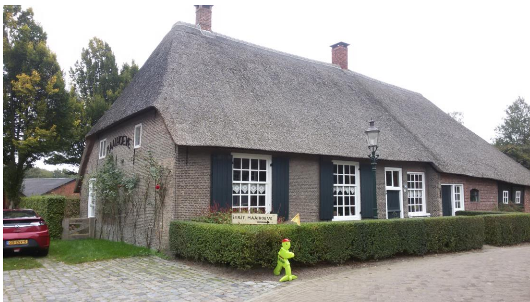
VOORZIJDE LANGGEVELBOERDERIJ DE MAAIHOEVE
