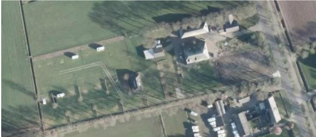
Figuur 1: Luchtfoto 2014 (cyclomedia)
