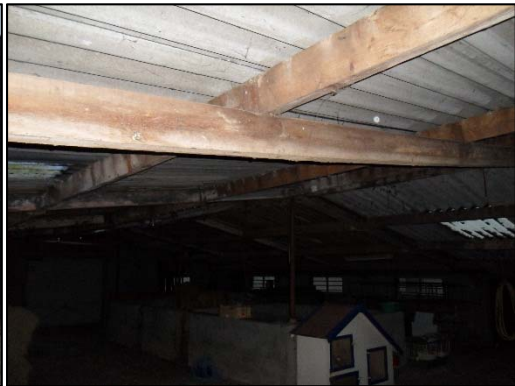
Foto 2. Dakconstructie te slopen bebouwing
