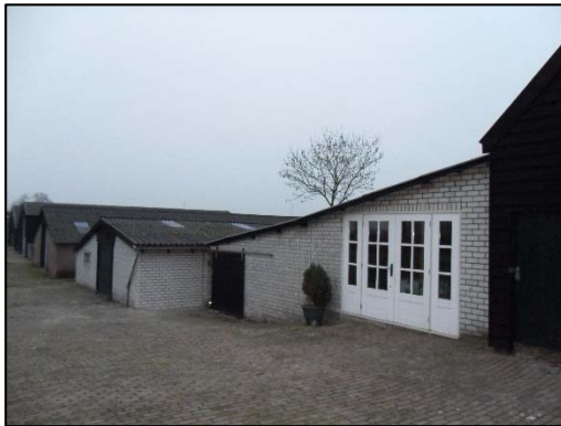
Foto 1. Te slopen bedrijfsbebouwing en verharding
