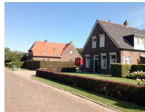
Zicht op bestaande woning vanuit het zuiden.
