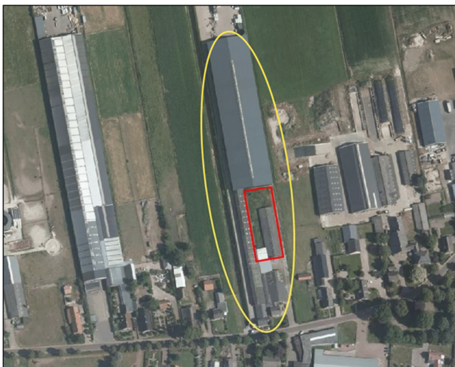
Figuur 1 luchtfoto van het plangebied met rood omlijnd het deel dat aan het bedrijf wordt toegevoegd
