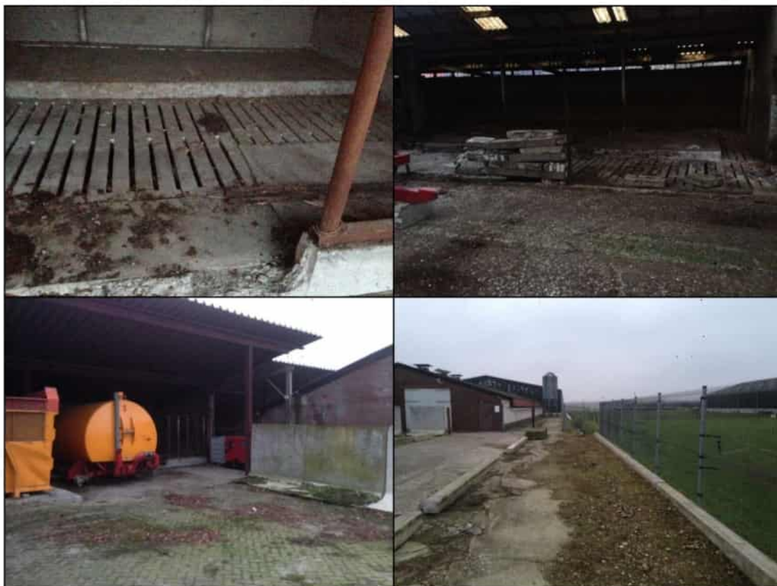
Figuur 10. Impressie van de situatie in het plangebied. Linksonder een indicatie van de mestkelders ter plaatse van de Ziekenboeg, rechtsboven een afbeelding van de situatie in de ligboxenstal. Linksonder een indicatie van de situatie ter plaatse van de boorpunten. Rechtsonder betreft een blik op de verharding aan de oostzijde van het terrein, buiten het plangebied. Hier is een ontwateringssloot gedempt.
