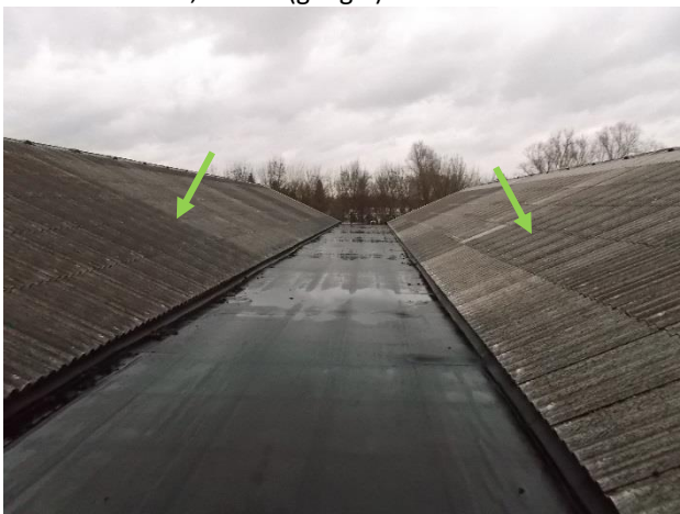
Foto 01: Dak, achter (gang 3)
