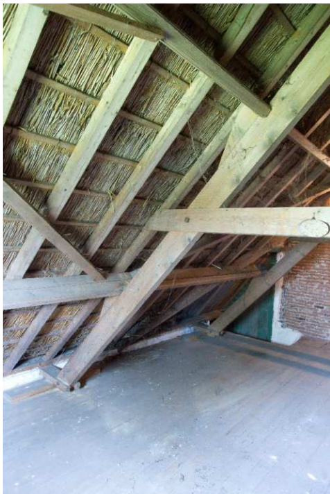
Afbeelding 1.07: Deel van één van de spanten boven het woongedeelte. De constructie is aangebracht in het eerste kwart van de twintigste eeuw.
