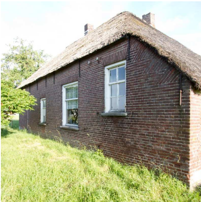
Afbeelding 1.04: Op het zuiden gerichte gevel met een zekere dynamiek door afmetingen en plaatsing van de vensters. Het hoog geplaatste venster rechts toont aan dat er een kelder met opkamer moet zijn geweest.
