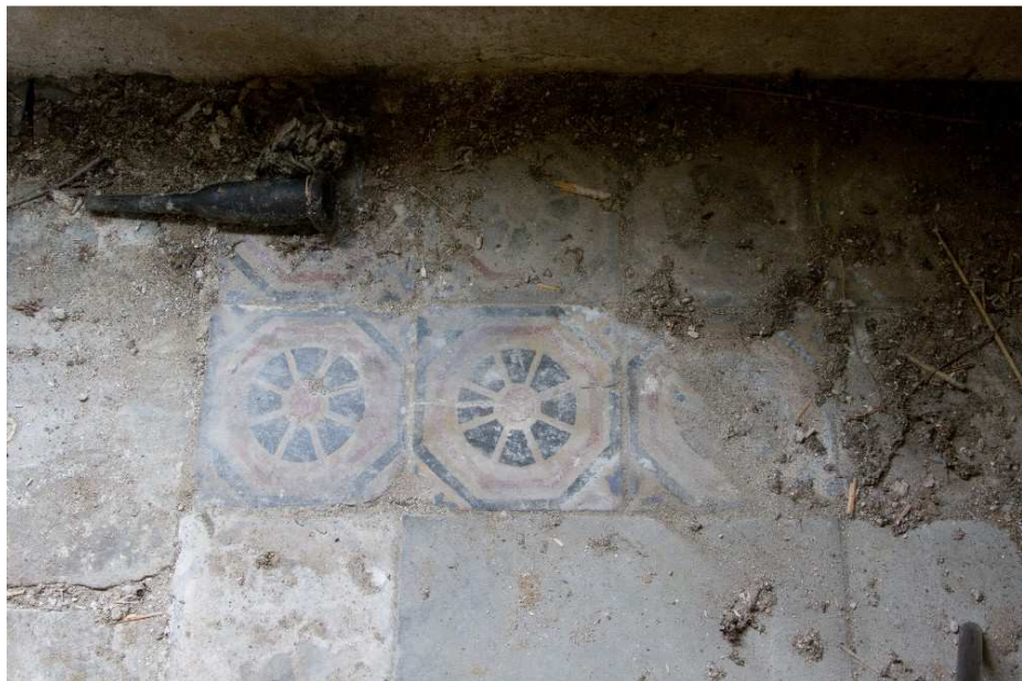
Afbeelding 1.23: Diversiteit aan tegels, natuursteen en klinkers in de vloer van het bakhuisje.
