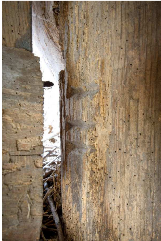
Afbeelding 1.17: Detail van het gehakte telmerk III op één van de gebintstijlen.
