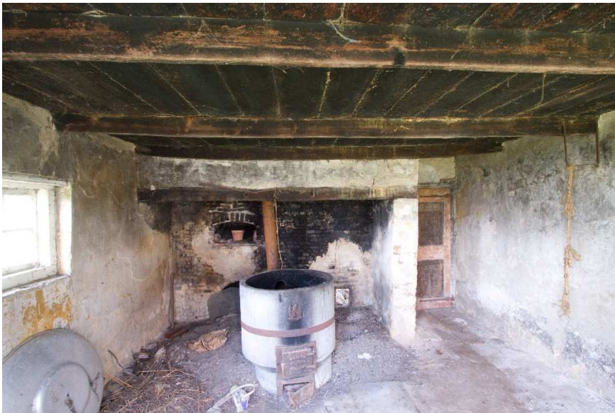
Afbeelding 1.21: In het bakhuisje de schouw met daarin verwerkt de stookmond en de ovenmond.
