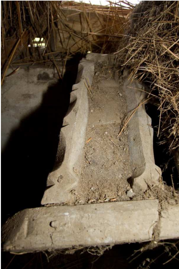
Afbeelding 1.19: Detail van de rijke bewerking van de hooiwagen waarvan restanten als vloerplanken op de zolder zijn hergebruikt.
