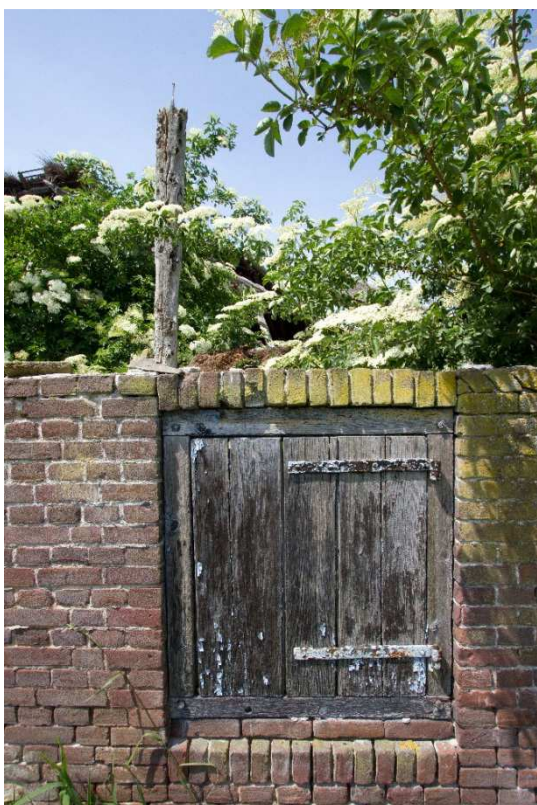
Afbeelding 1.26: Een luik in de zuidgevel van de Vlaamse schuur met in de onderdorpel ongebruikte toognagelgaten die wijzen op hergebruik.
