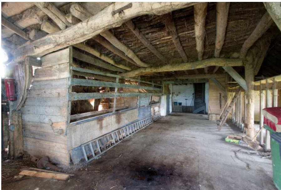
Afbeelding 1.15: De stal van de boerderij gezien vanaf de deeldeuren. Driebeukige opzet met links een paardenstal (later toegevoegd).
