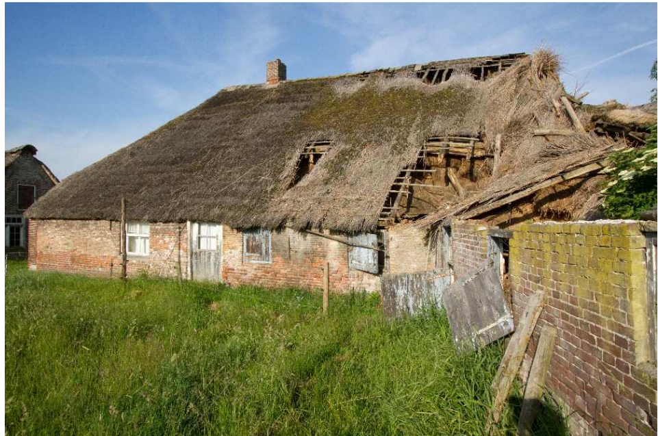
Afbeelding 1.05: De op het oosten gerichte zijgevel van het woongedeelte met hergebruikte materialen, een hergebruikt venster en een dichtgezette kelderopening.
