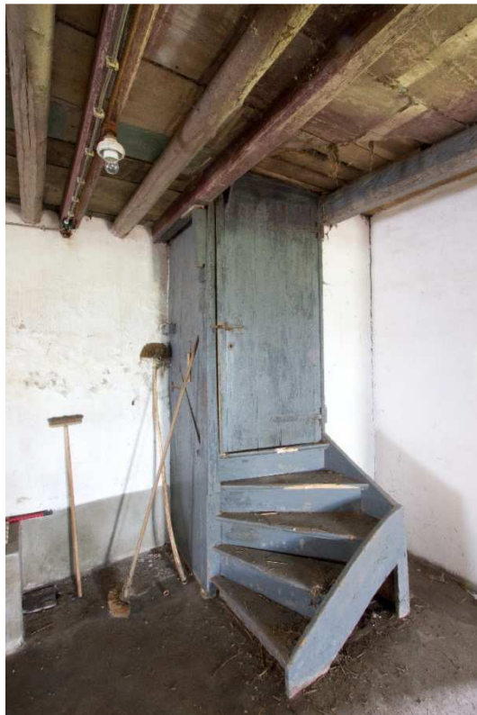
Afbeelding 1.18: In de stal de trap naar de zolder. Aanvankelijk zal de trap zijn afgescheiden van de stal door middel van een schot.
