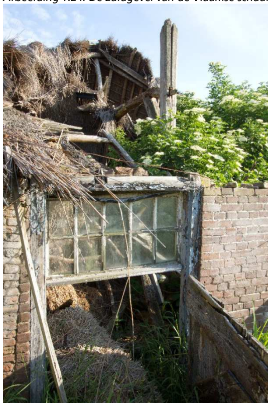
Afbeelding 1.25: Mogelijk nog laat achttiende-eeuws kozijn met bovenraam hergebruikt in de zuidgevel van de Vlaamse schuur.
