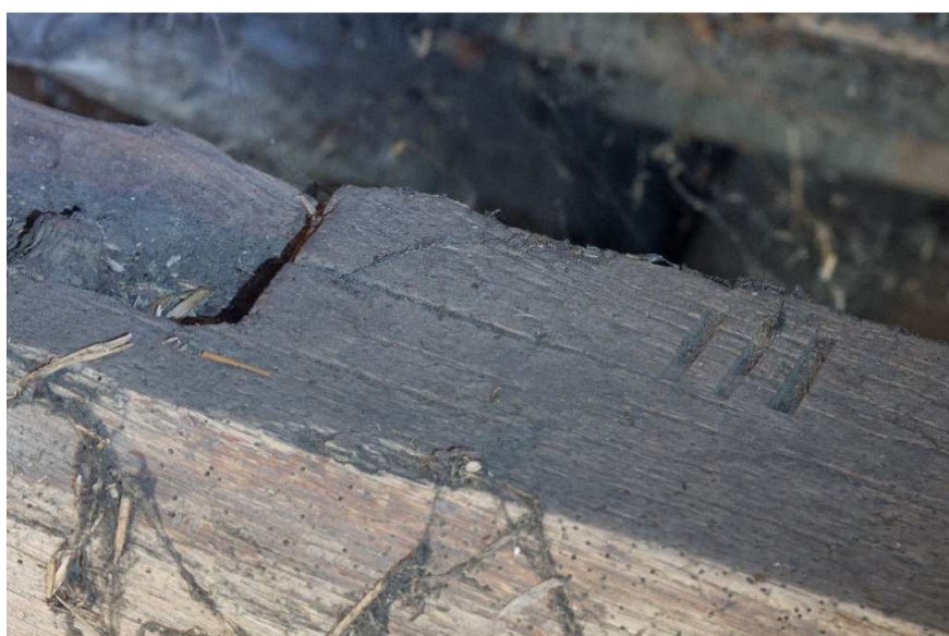
Afbeelding 1.09: Op de gebintplaat inkepingen en gehakte merken ten behoeve van verdwenen sporenparen.
