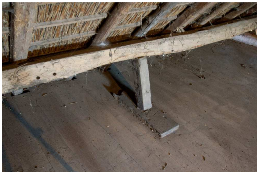
Afbeelding 1.08: Restant van een gebintplaat met daarin sporen van een verdwenen stijl en enkele korbeels.
