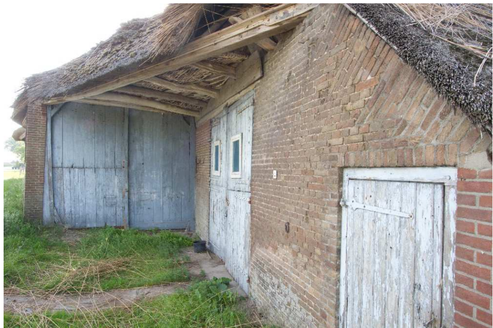
Afbeelding 1.06: In hoge mate karakterbepalend de kopgevel van het stalgedeelte en de aansluiting van de deeldeuren van de Vlaamse schuur, gekoppeld onder een huif met twijgendek. De deur in de voorgrond is een toevoeging.
