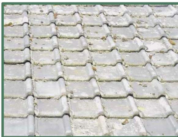
Aansluitend pannendak paardenstal
