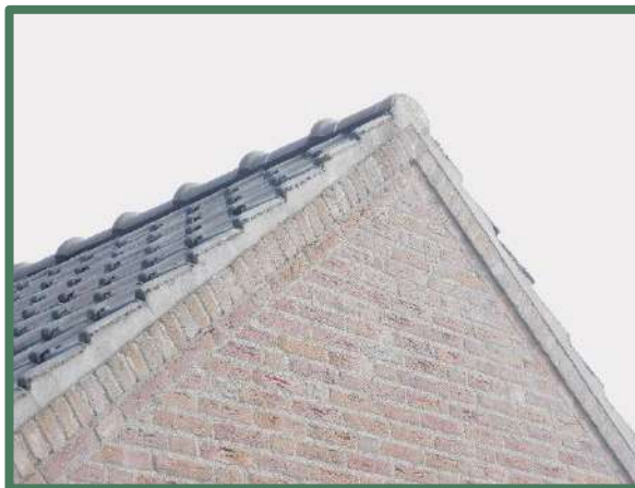
Aangesmeerd en afgesloten dak paardenstal
