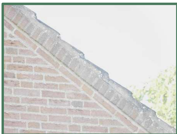
Aangemeerd en afgesloten pannendak woning
