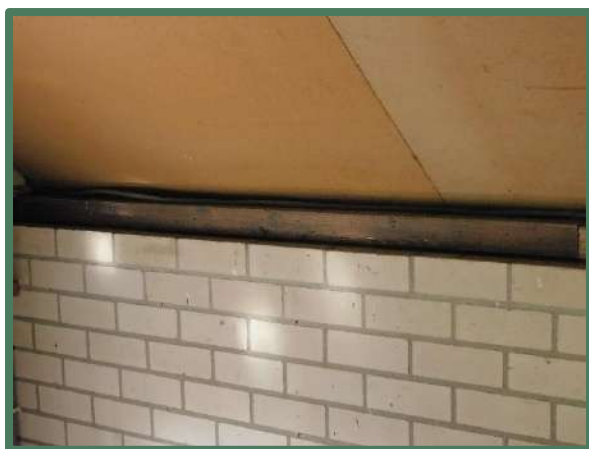
Muurplaat op spouwmuur paardenstal
