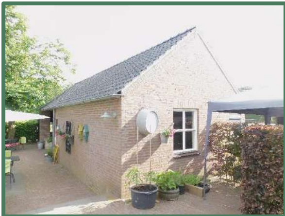
Te slopen paardenstal voorzijde
