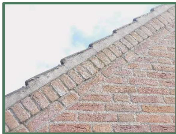
Aangesmeerd en afgesloten pannendak paardenstal
