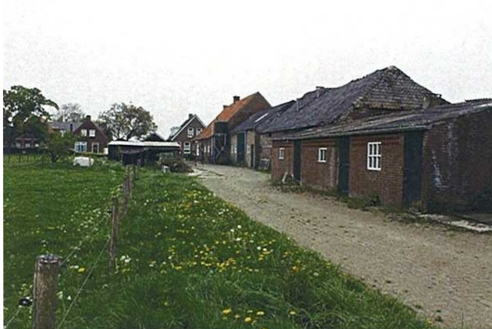
Afbeelding 8 - Foto overzicht bestaande bedrijfsbebouwing.
