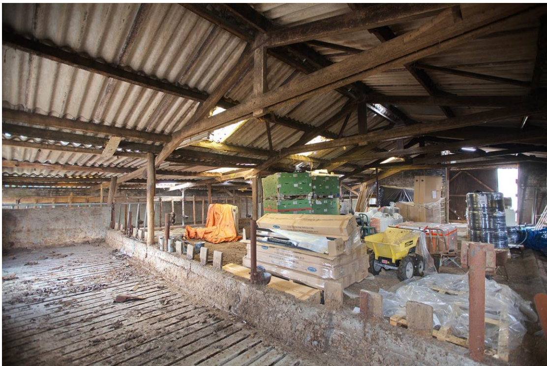
Figuur 12: doorkijk door de oude te slopen koeienstal (westelijk deel)
