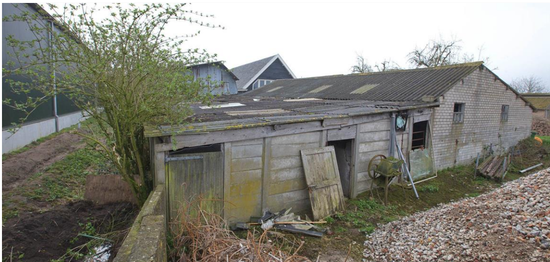
Figuur 15: achterzijde koeienstal met vlier
