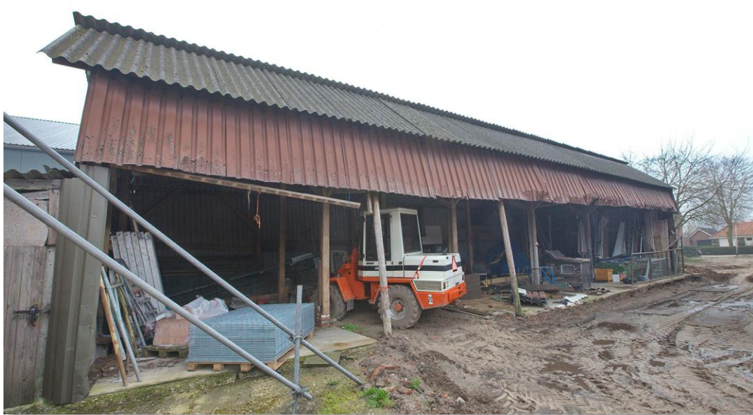
Figuur 9: aanzicht te slopen loods met open front
