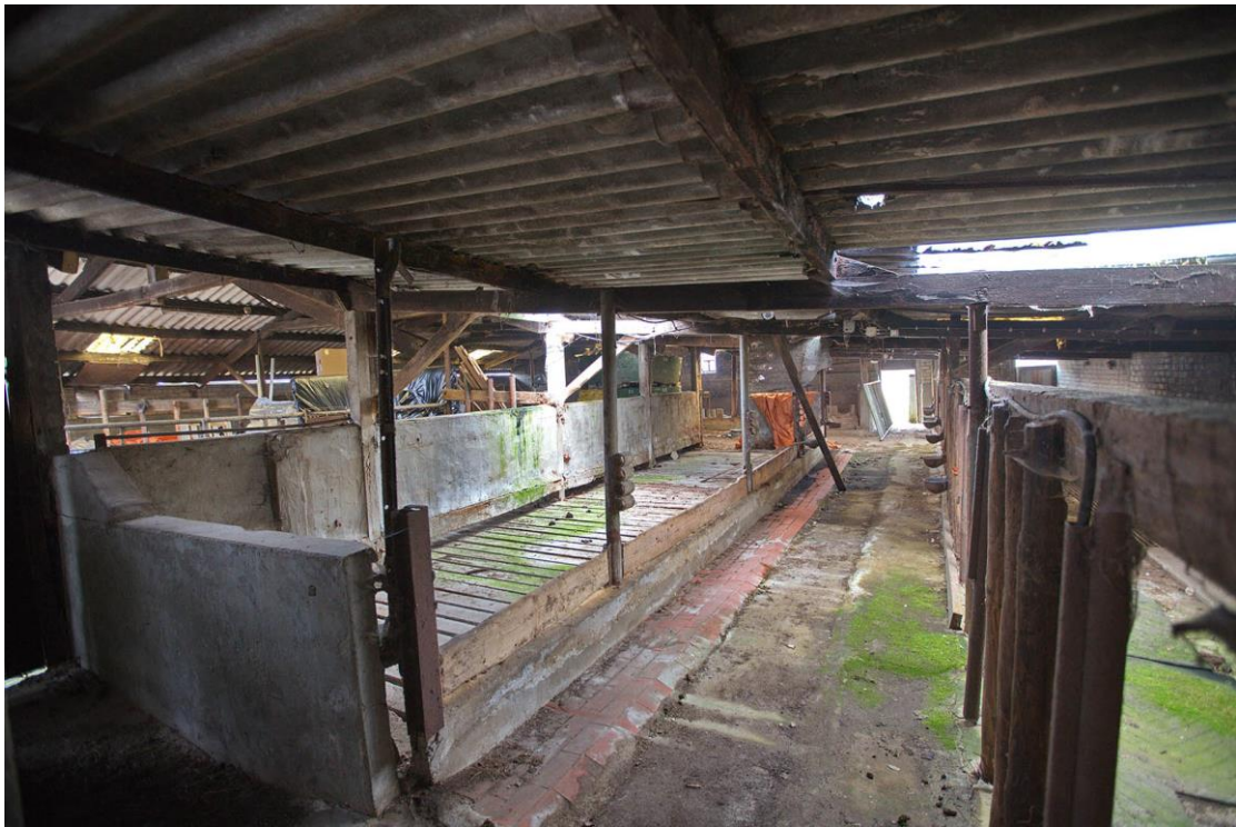
Figuur 13: doorkijk door de oude te slopen koeienstal (oostelijk deel)
