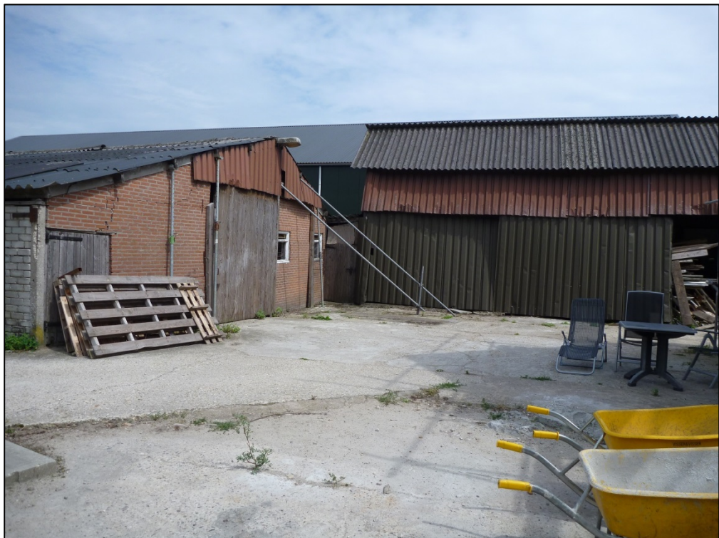
Foto 3 links de bestaande vrijstaande stal rechts de open loods
