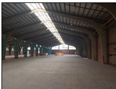
Figuur 7. Binnenzijde centraal gelegen loods (Vijfhoevenlaan 8).
