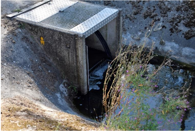
Afbeelding 4 – Huidige stuw t.h.v. Mommersteeg
