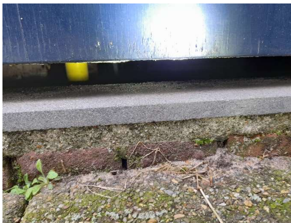
Figuur 7. Kast aan de buitenkant van de kantine
