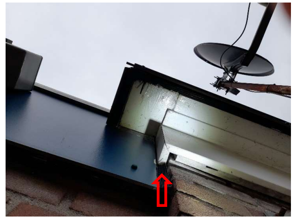
Figuur 8. Toegankelijke ruimte in dakbeschoot
