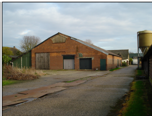
Foto 8. de twee schuren vanaf het erf gezien
