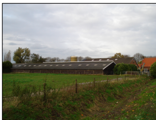
Foto 2. het plangebied gezien vanaf de Achterweg met rechts de twee schuren en het woonhuis
