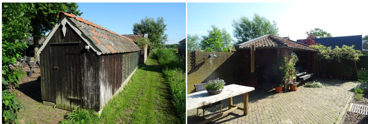
Afbeelding 3 en 4: bestaande te slopen bijgebouwen op de kavel. Bron: R.J.L. Bijvelds 16-06-2021
