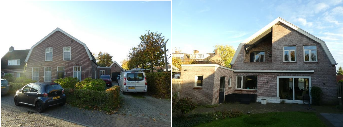
Afbeelding 3 en 4: Te slopen woning. Bron: BNL advies. Datum: 26-10-2022
