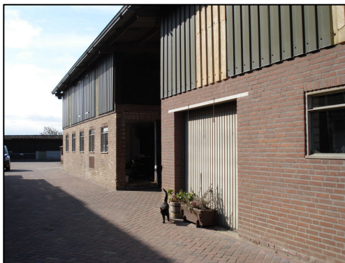
Foto 3. Te slopen voormalige koeienstal
