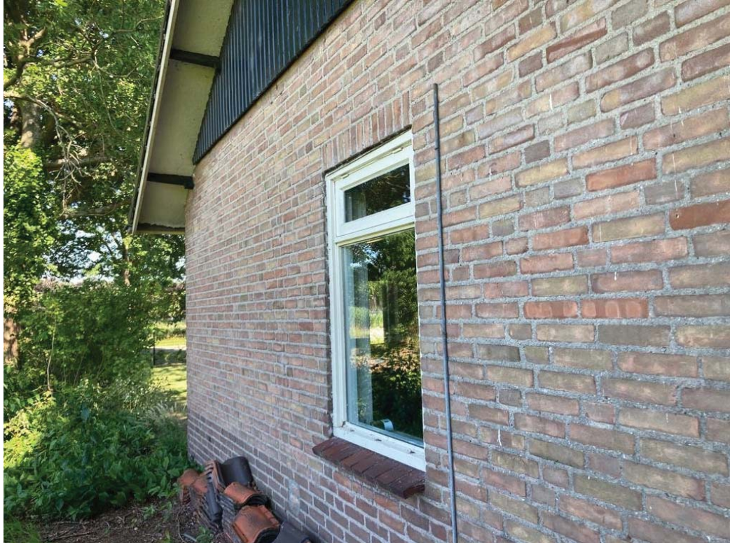
• Afbeelding 6: te slopen woonhuis
