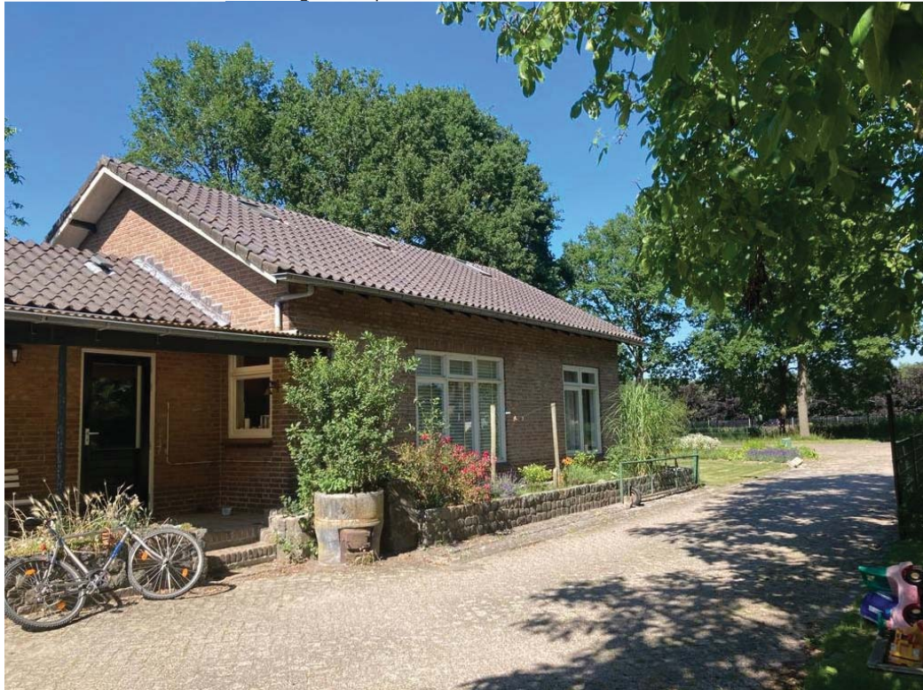
• Afbeelding 3: te slopen woonhuis
