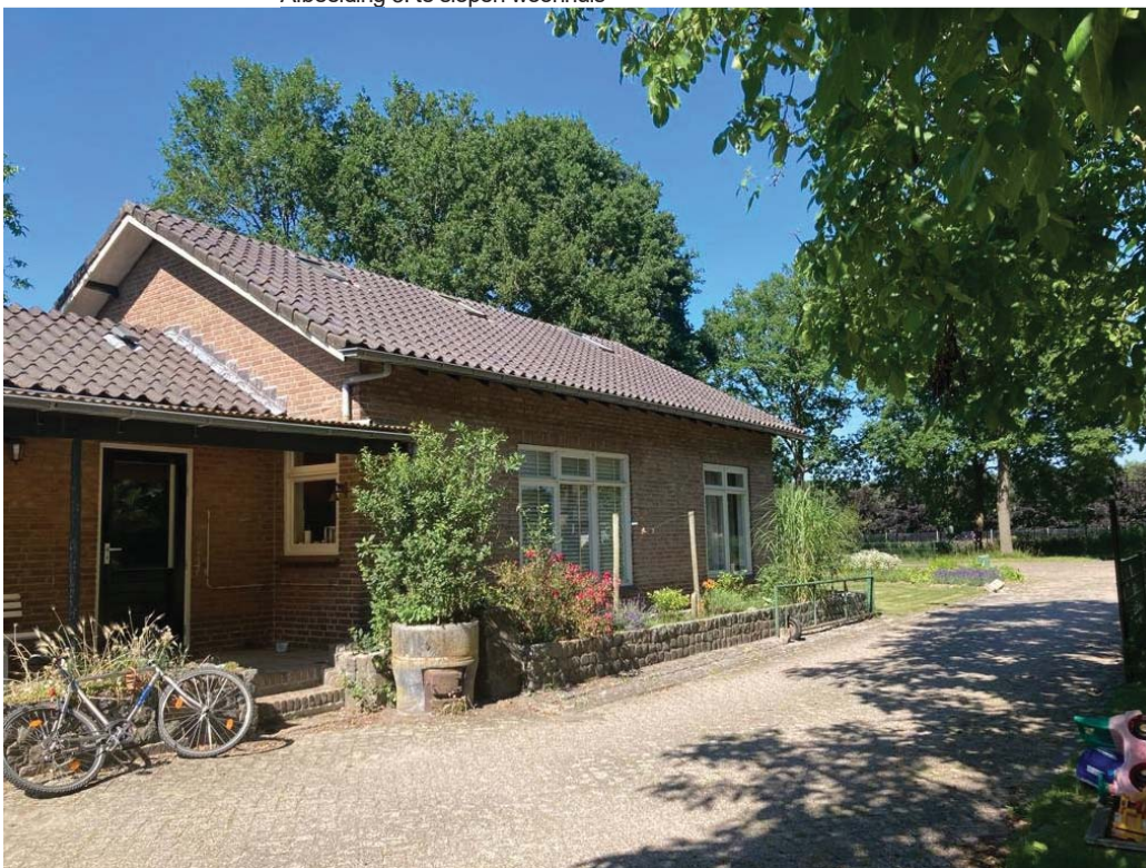
• Afbeelding 3: te slopen woonhuis
