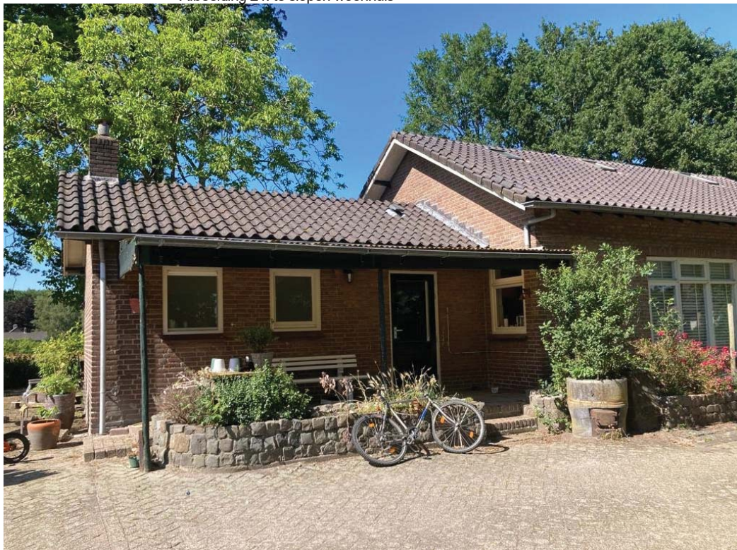
• Afbeelding 21: te slopen woonhuis
