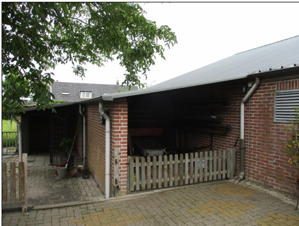
Figuur 2 De noordzijde van de loods.
