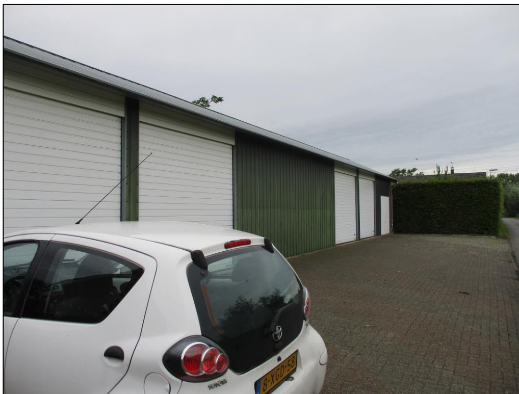
Figuur 1 Het noordelijke deel van de loods zal gesaneerd worden.
