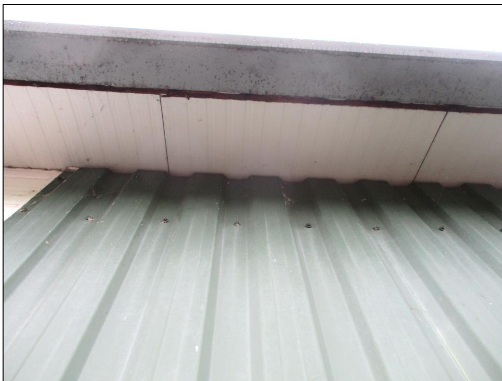
Figuur 3 Door de aanwezigheid van damwand dakbeplating en isolatieplaten is er geen (kruip)ruimte aanwezig. De aanwezigheid van vaste rust- en verblijfplaatsen van gebouwbewonende vleermuizen kan uitgesloten worden.
