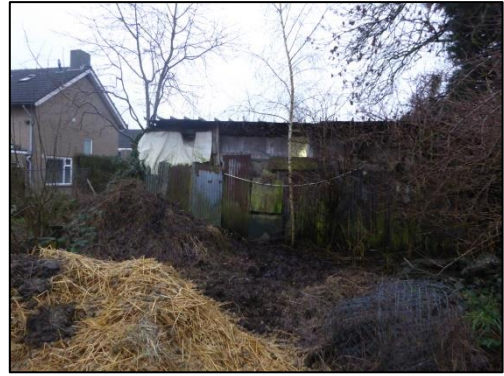
De paardenstal welke ook onderdeel uitmaakt van de deelsgesloopte woning;
