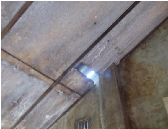
Afbeelding 14. Tweede opening in gebouw 2 vanuit binnen gezien (foto van binnenkant noordzijde)
