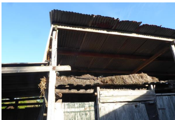
Afbeelding 12. Bebouwing 3 met een golfplaten dak (foto van zuidzijde bebouwing)
