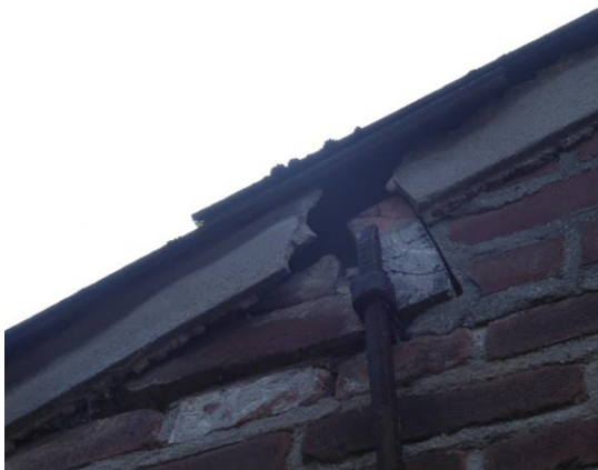
Afbeelding 13. Opening in gebouw 2 tussen de dakplaten en de bakstenen muur (foto van buitenzijde noordzijde gebouw)
