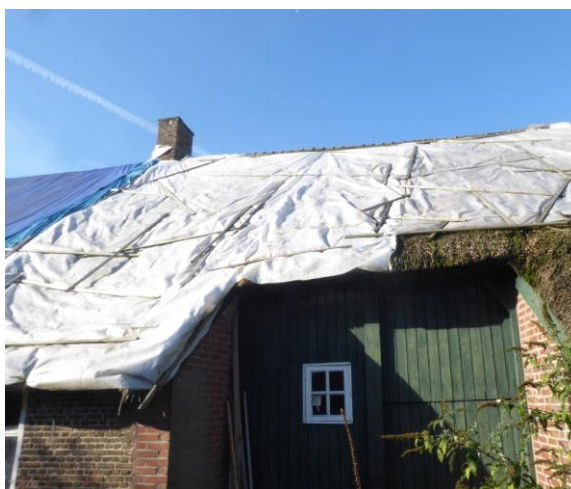
Afbeelding 10. Gebouw 1, kortgevelboerderij, met een rieten dak dat deels bedekt/vervangen is met plastic zeil (foto vanuit oostzijde)
