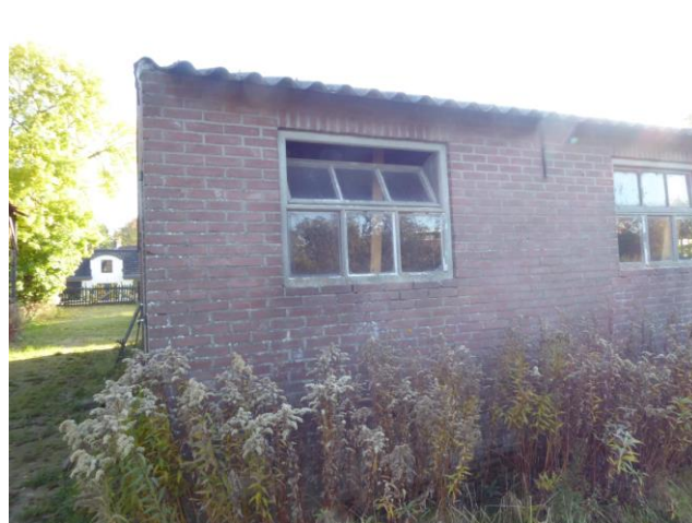
Afbeelding 5. Bijgebouw nr. 2 bestaande uit baksteen en een golfplaten dak (foto westzijde van het gebouw).
