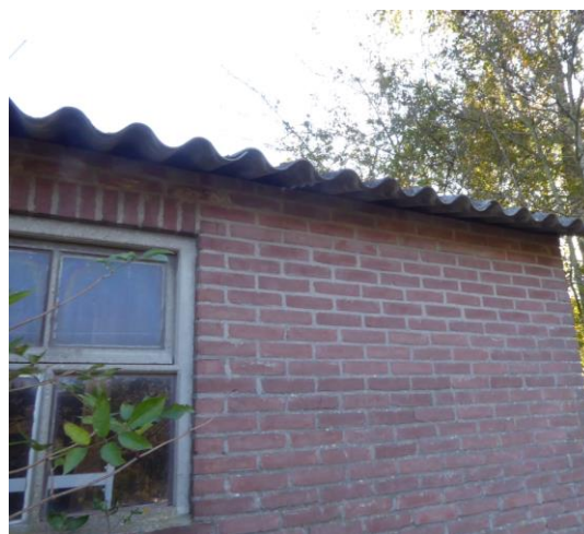
Afbeelding 11. Gebouw 2 met golfplaten dak (foto vanuit oostzijde)
