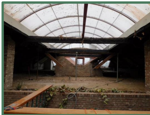
Uitzicht op de zolder vanuit het zuiden
