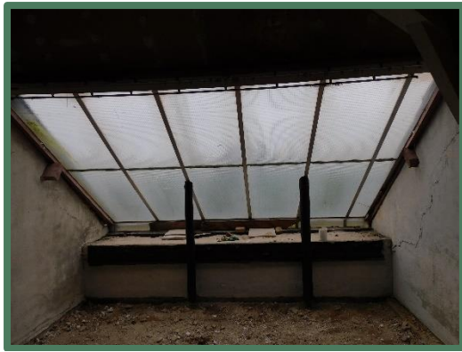
Dak boven fort
