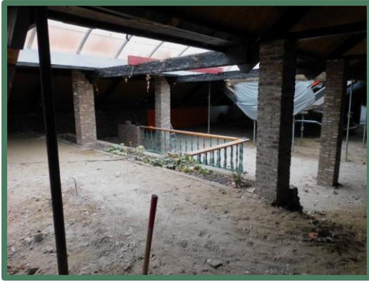
Uitzicht op de zolder vanuit het zuidoosten
