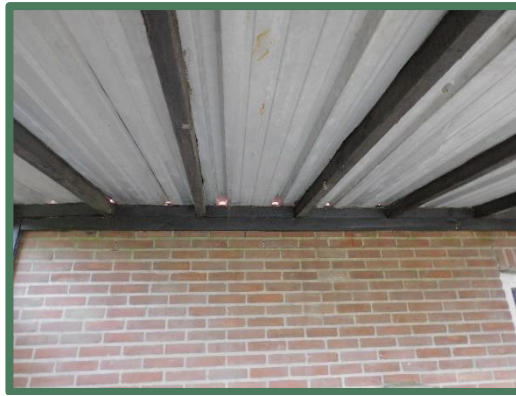
Dak te slopen bijgebouw
