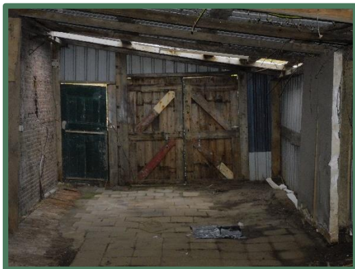
Binnenzijde zuidwestelijke schuur
