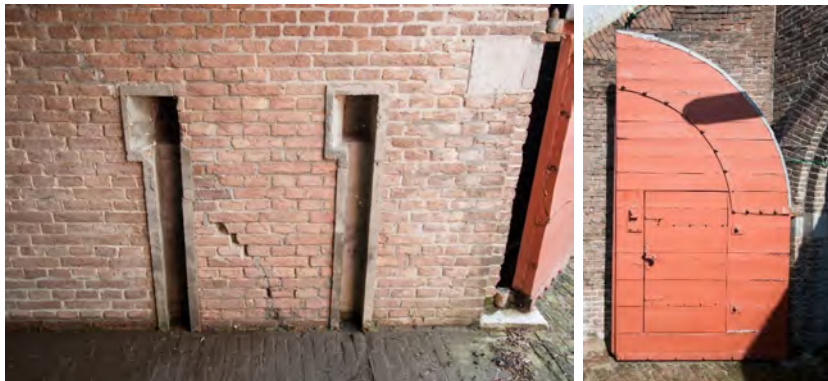
De schotbalksleuven zijn vermoedelijk secundair, doch zeker van vóór 1933 (foto Werk bij Bernsche Hoeven uit 1933 laat schotbalksleuven zien, maar op de bouwtekeningen uit 1862 ontbreekt hiervan ieder spoor). Rechts één van de buitendeuren.
