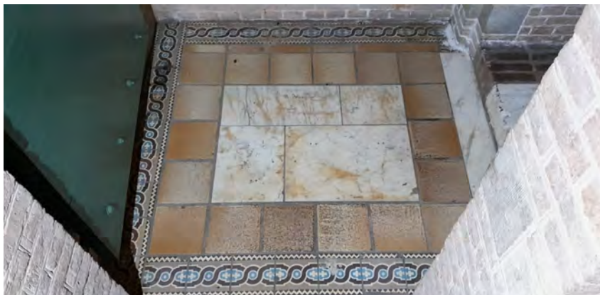
Herinnering aan de bouwmaterialenhandel van de vorige eigenaars, een eigenaardige combinatie van vloertegels in het portaal van het kruitmagazijn. Oorspronkelijk lag hier een houten vloer, op het niveau van alle klinkervloeren.
