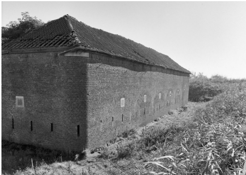
De achtergevel in 1972. Onder de schietsleuven zijn enkele (korteling)gaten te zien, die thans nog bestaan.
