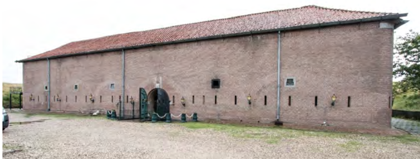
De voorgevel van het gebouw in de huidige toestand, met detonerende lantaarns en regenpijpen.
