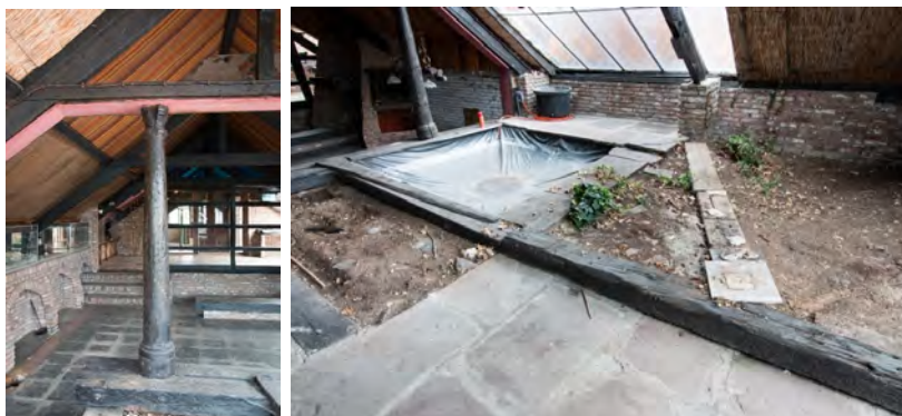
De hergebruikte houten zuil op de overgang van binnentuin naar zitkuil. Rechts de binnentuin met voormalige waterbassin.
