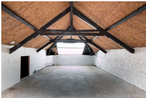
Cementvloer, kalkzandsteen en rietmatten op de zolder. Door wegzagen van trekbalken en schade aan spanten is de borstwering van de buitengevel naar buiten gedrukt. Rechts een restant van de negentiende-eeuwse zakgoot. Oorspronkelijke (grond)poeren zijn in de jaren zeventig ommetseld.
