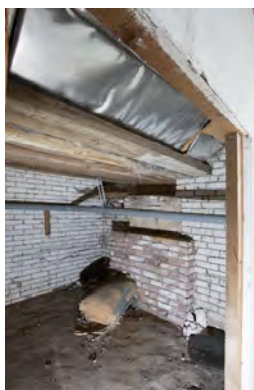
Cementvloer, kalkzandsteen en rietmatten op de zolder. Door wegzagen van trekbalken en schade aan spanten is de borstwering van de buitengevel naar buiten gedrukt. Rechts een restant van de negentiende-eeuwse zakgoot. Oorspronkelijke (grond)poeren zijn in de jaren zeventig ommetseld.
