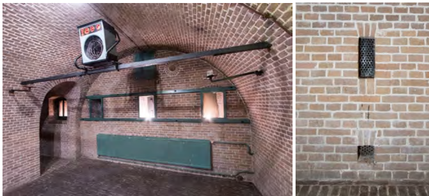
Ruimte 12. Rechts ventilatieopeningen met negentiende-eeuwse roostertjes intact.
