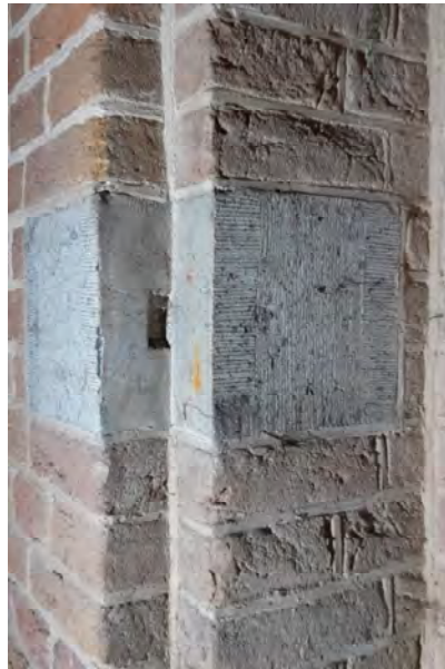
Natuurstenen blokken met vrijslag langs de randen in de dagkanten, ten behoeve van de deursloten.
