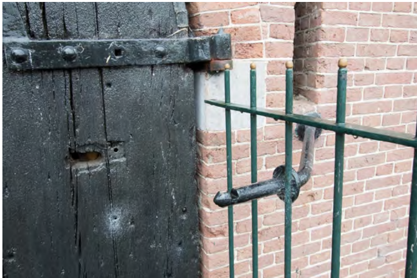
De beugel voorkwam van meet af aan dat de deuren boven de gracht doorzwenkten en daardoor niet makkelijk meer te sluiten waren. Ook voorkwam het ongewenst dichtwaaien, doordat sluiting in geopende stand mogelijk was.
