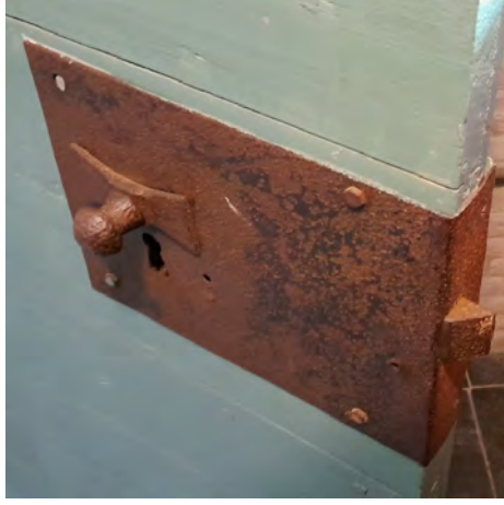
Ventilatieopeningen en negentiende-eeuws deurslot (opnieuw vastgezet).
