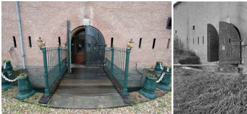
De entreepartij met brug. Rechts de situatie in 1972, wanneer een loopplank als brug fungeert.
