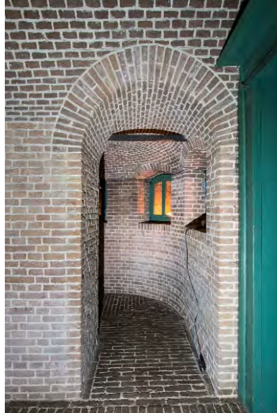
Doorgang vanuit de keuken, met deursponning en dubbele boog. Rechts doorgang langs de afgeronde buitenhoek.
