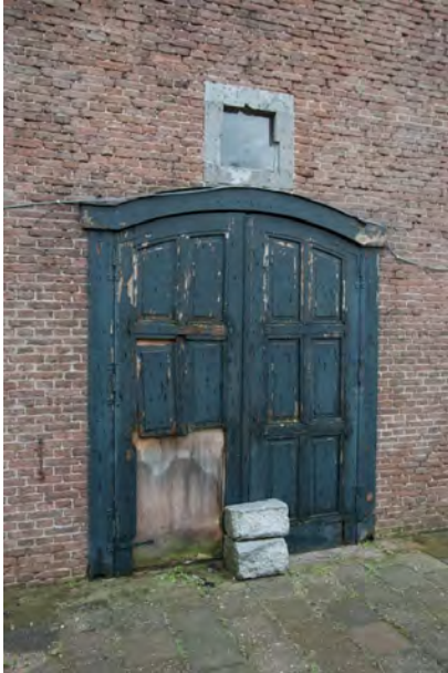
De secundaire deurpartij in de rechter zijgevel, tot stand gebracht in de jaren zeventig van de vorige eeuw, met behulp van hergebruikte deuren en lijstwerk (herkomst onbekend).
