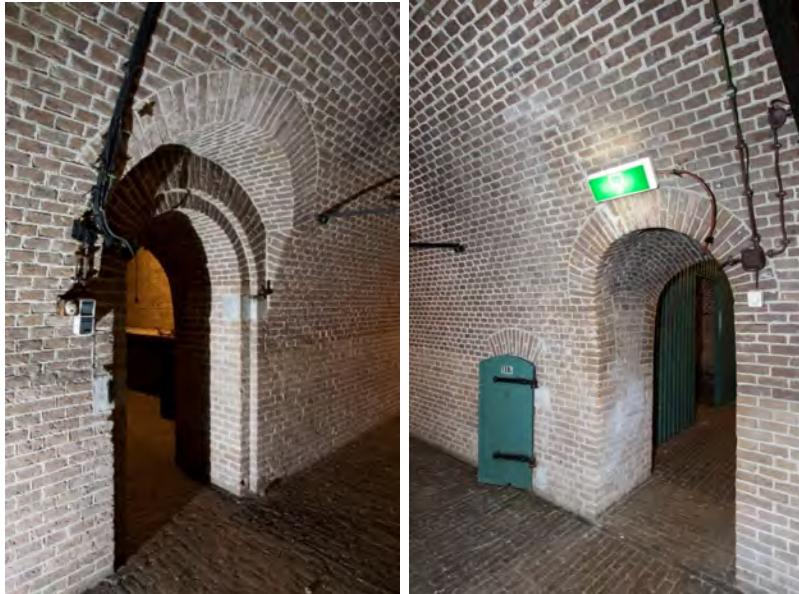
De doorgang naar de keuken heeft een naar binnendraaiende deur gehad. De doorgang naarlangs het levensmiddelenmagazijn is zonder deursponning uitgevoerd.
