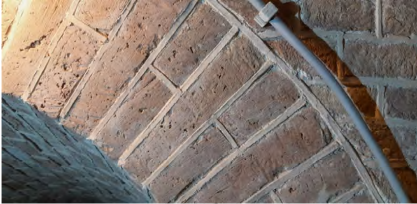
Geslepen bakstenen in een boog. De stenen hebben een duidelijke wigvorm gekregen.
