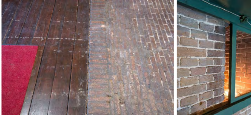
De aansluiting van de gereconstrueerde houten vloer op de oorspronkelijke klinkervloer. We zien dat de rollaag met portlandcement is gemetseld, wat wijst op herstelling van de rollaag en het begin van de vloer én dus ook de oorspronkelijkheid van het met veel wittere voeg gemetselde klinkerwerk rechts daarvan. Op de foto rechts de paarsere (hardere) baksteen in de dagkanten van de schietgaten.
