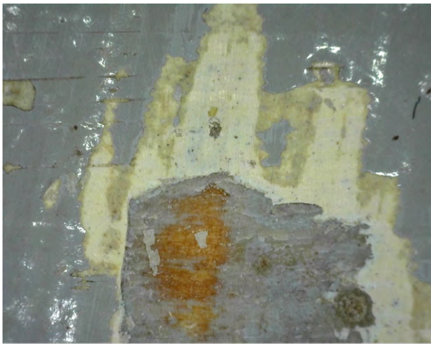
Op de deur met ruimtenummer 7 is een insnede gemaakt om de oudst aanwezige verflagen in het zicht te brengen. Dit is een microscopopname van die insnede waarop de we grijze verflaag uit 1862 op het hout zien aangebracht.
