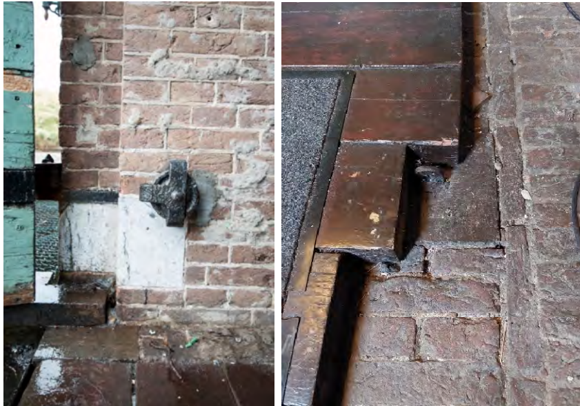
Eén van de twee katrollen die werden gebruikt om de brug naar buiten te kunnen rollen. De katrol is bevestigd aan een duimblok. Rechts een natuurstenen blok dat ook met de rolbrug te maken heeft. Het blok vormt mede het bewijs dat de klinkervloer oorspronkelijk moet zijn.
