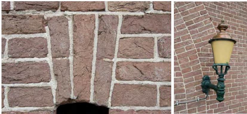
De buitenste strekken in de strekse boog zijn uitgevoerd met schijnvoegen. Rechts één van de secundaire lantaarns.
