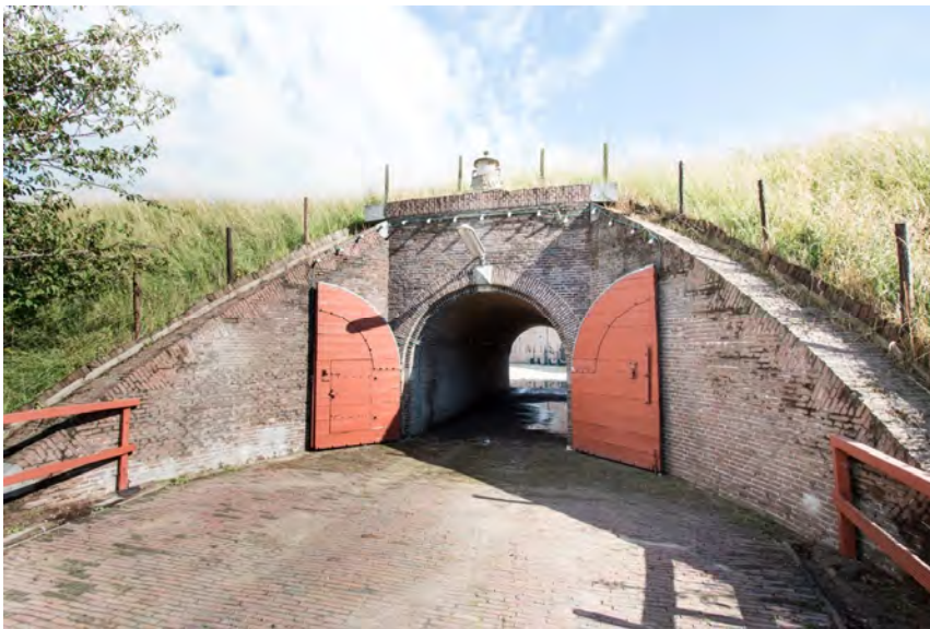
De buitenzijde van de poterne. Randen van de vleugelmuren zijn vernieuwd/hersteld, zo is van oude foto's af te lezen.
