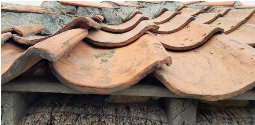
Oud Hollandse pannen, mogelijk nog gedeeltelijk uit de bouwtijd.
