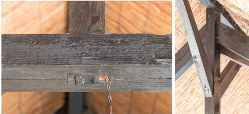
Detail van de ranke, dubbel uitgevoerde trekbalkjes die aan elkaar gespijkerd zijn en in het midden halfhouts de nokstijl inklemmen. Rechts een detail van de top van de constructie.
