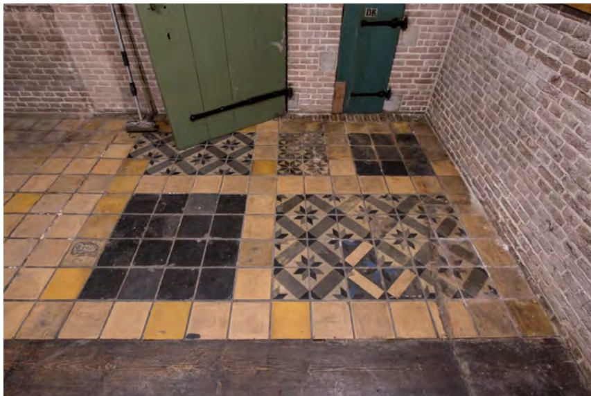
Een deel van de vloer is negentiende-eeuws, een ander deel is geplaveid met laat negentiende-eeuwse plavuizen die van elders afkomstig zijn en hier zijn hergebruikt.
