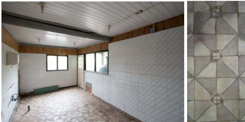
Het interieur van de aanbouw tegen de linker zijgevel van het bomvrije gebouw.
