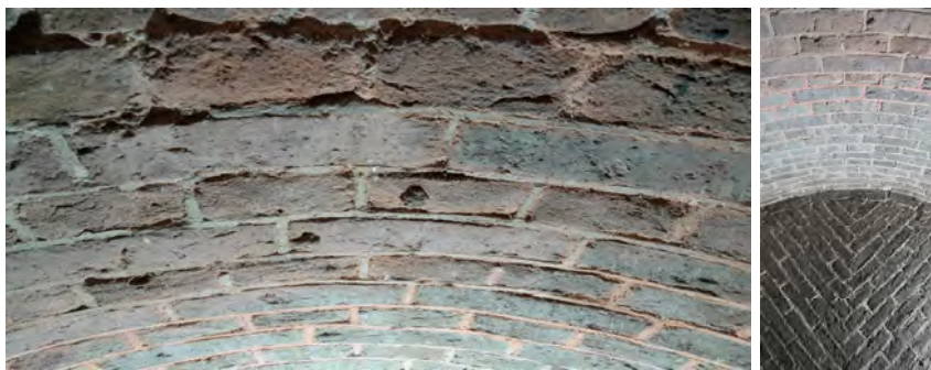
Op de afgeronde hoeken alterneert de ruwe koppenlaag met een hol en glad geschuurd/geslepen strekkenlaag, wat een bijzonder fraai effect geeft.
