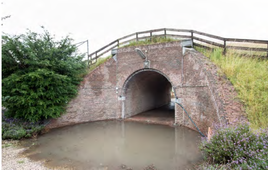
De poterne aan de binnenzijde, ontdaan van deuren en met herstelde randen. Er is zorgvuldig gerestaureerd. Spijtig is wel dat er met portlandcement is gewerkt.
