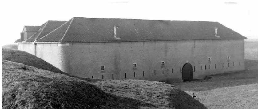
Opname uit 1933 van het dan te slopen fort bij Bernsche Hoeven (het gebouw is identiek), nog met schoorstenen intact. De walgang is op de foto goed herkenbaar.
