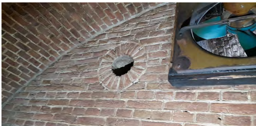
Links de openingen ten behoeve van een verdwenen kachelpijp. Rechts een ventilator in een venster gewerkt.
