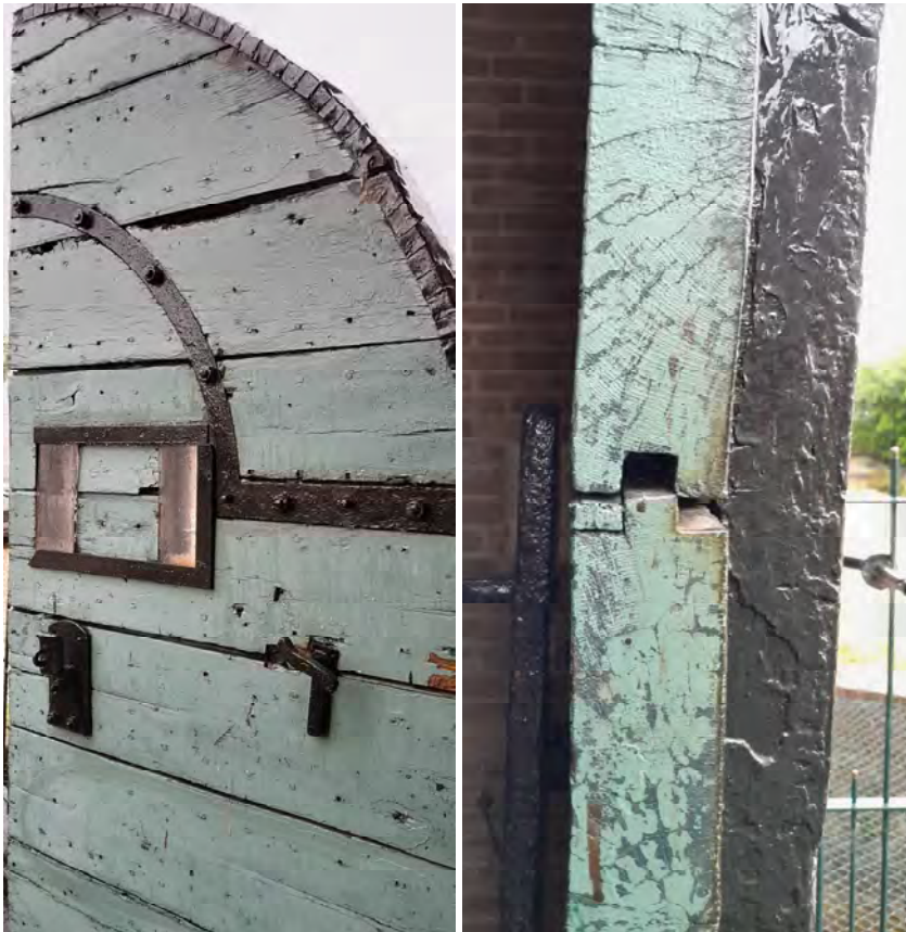
Deurdetails met oorspronkelijk hout- en ijzerwerk. Uit het bouwbestek is op te maken dat de schietgaten in de deuren altijd met kleine raampjes en leilatten af te sluiten zijn geweest.
