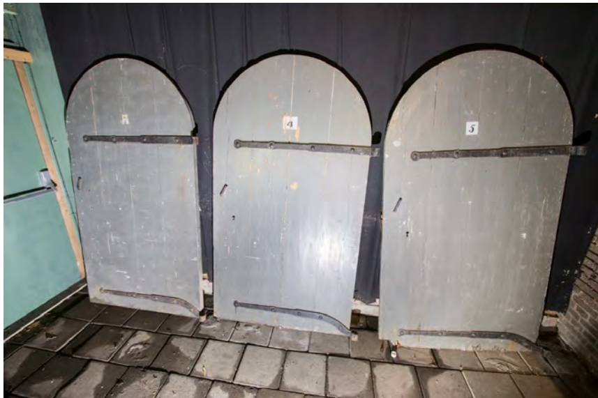
Drie oorspronkelijke deuren zijn in opslag genomen. De kleurstelling is zoals is aangegeven in het bouwbestek, grijs. Sloten en grendels zijn verwijderd en verdwenen.
