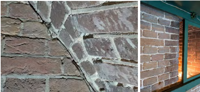
Gewelven in een hardere (paarsrode) baksteen steken door bovenlangs de opstand. Hardere stenen ook in de dagkanten van de schietsleuven.
