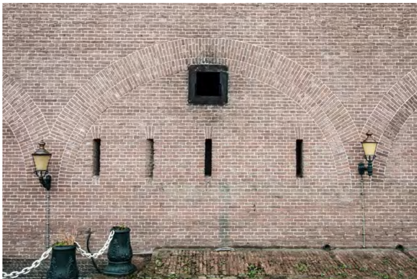
De schietsleuven zijn het dichtst bijeen geplaatst nabij de entreepartij.
