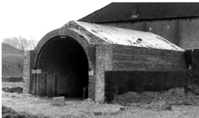
Opname uit 1933 van de ontmanteling van het werk bij de Bernsche Hoeven. We zien duidelijk de aanrazing én ook de schotbalksleuven. Indien die sleuven niet oorspronkelijk zijn, zijn ze in ieder geval (ruim) voor 1933 aangebracht.
