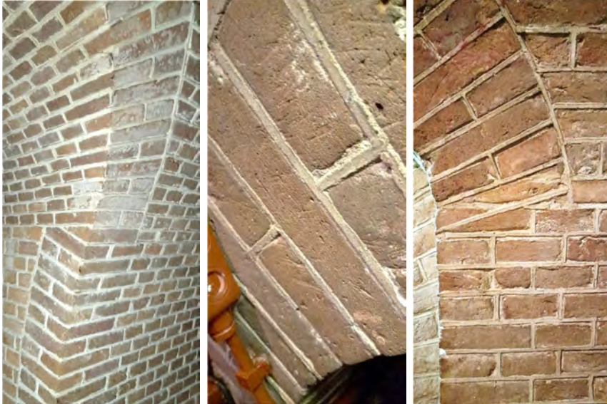
Gewelven. Op de foto rechts is het geslepen oppervlak van de boogstenen vrij goed te zien. Voegwerk uit de bouwtijd.
