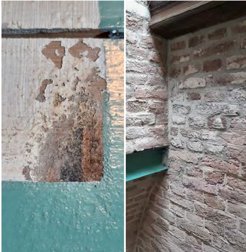
Sporen van overschildering van een deur. Rechts doorbreking van het gewelf van het projectielenmagazijn.
