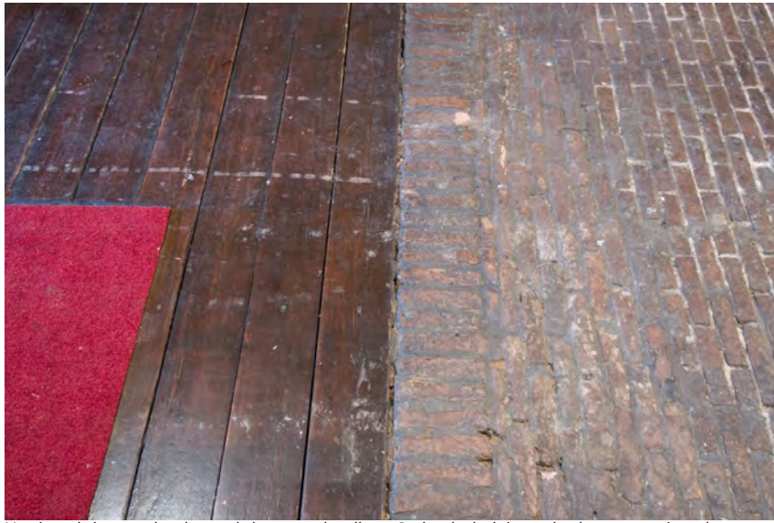
Vernieuwde houten vloer boven de kast voor de rolbrug. Rechts de deels in portlandcement vernieuwde klinkervloer die daarop aansluit.
