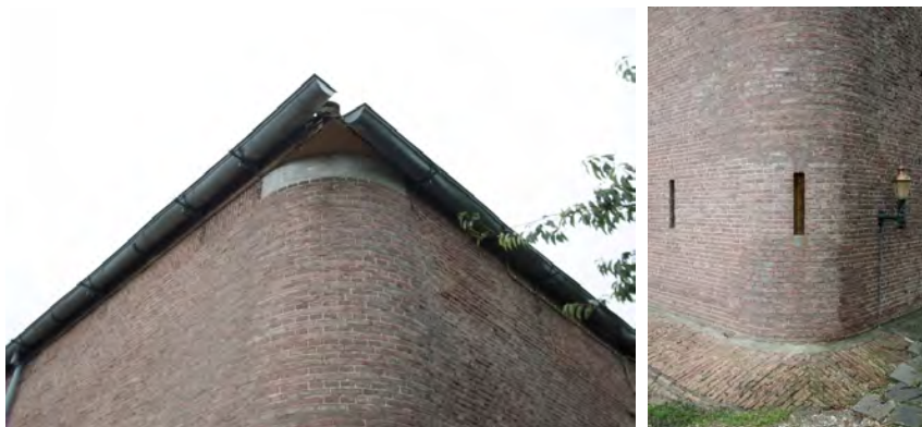
In hoge mate karakteristiek zijn de afgeronde hoeken. De wat curieuze dakaansluiting lijkt van meet af aan bestaan te hebben. Rechts een voordeel van een afgeronde hoek, plaatsing van een schietsleuf is betrekkelijk eenvoudig.
