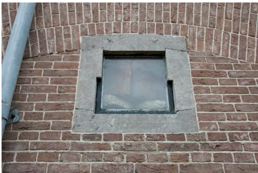
Eén van de vensteropeningen, in natuursteen uitgevoerd. Vermoedelijk dateren de ijzeren ramen uit de jaren zeventig, al zou er ook nog best ergens een negentiende-eeuws exemplaar bewaard gebleven kunnen zijn.
