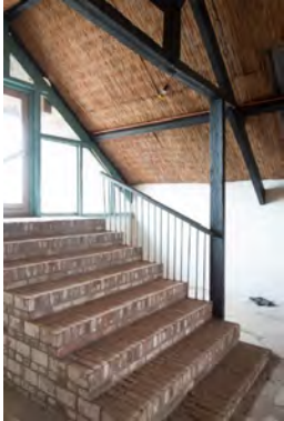
Bakstenen trap met hergebruikte balusters. Rechts het resultaat van hergebruik van verschillende partijen sloopmateriaal.
