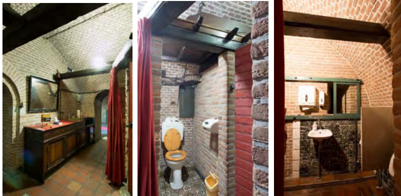
Wat vermoedelijk als wachtruimte bedoeld is, is omgevormd tot ruimte met sanitaire voorzieningen. Dat lijkt ten kosten gegaan te zijn van de oorspronkelijke klinkervloer.
