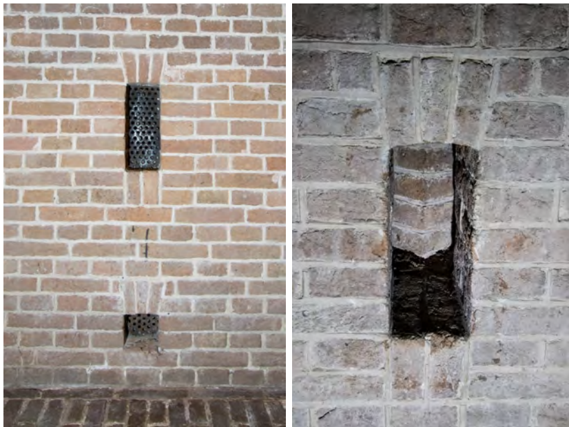
Ventilatieopeningen van het kruitmagazijn, links van buitenaf gezien, rechts van binnenuit.
