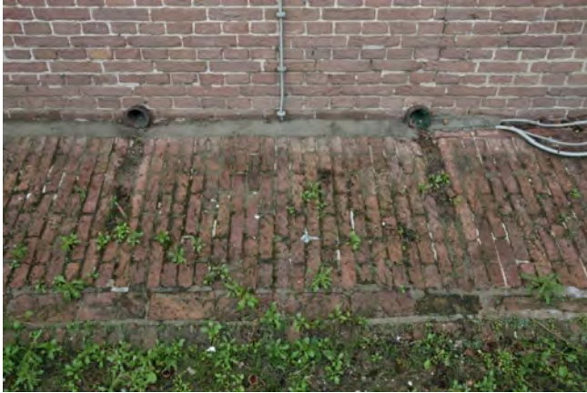
De rabat langs de voorgevel. De buizen in de gevel zijn vuilwaterkokers van gietijzer, zoals in het bestek beschreven. Deze openingen werden standaard aan de binnenzijde afgesloten met een eiken stop en ring.
