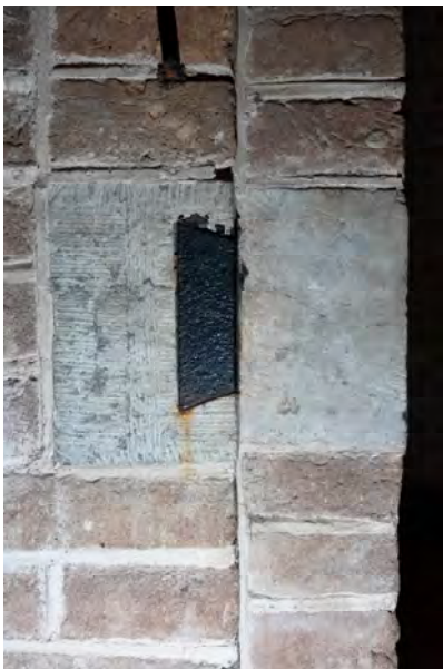
Natuurstenen blokken met vrijslag langs de randen in de dagkanten, ten behoeve van de deursloten.
