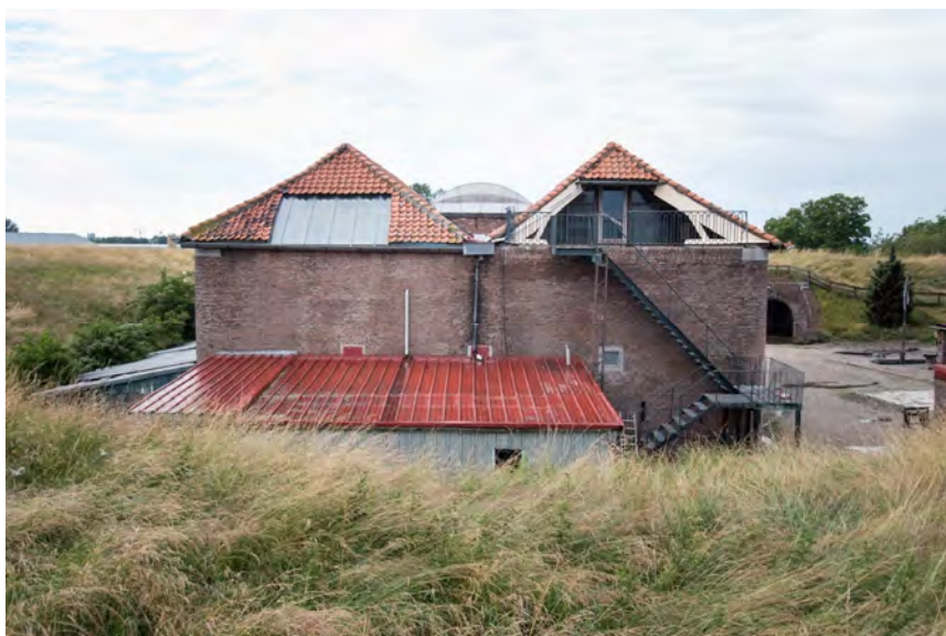
De linker zijgevel in huidige toestand.
