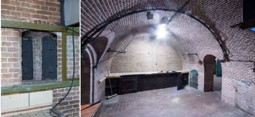
Het dubbele schietgat lijkt niet gefunctioneerd te kunnen hebben vanwege het fornuis. Het fornuis is op een enkele negentiende-eeuwse tekening (de tekening op linnen) al te zien en moet dus wel oorspronkelijk zijn.
