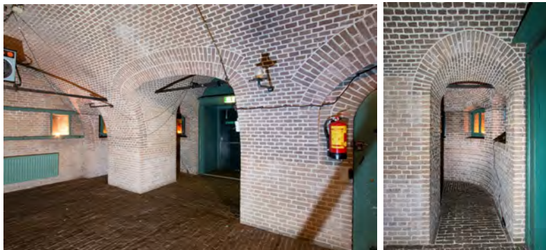
De ruimte 1a, is voorzien van een secundaire buitendeur. Een gangetje leidt langs de schietgaten in de afgeronde hoek. Hier zijn de trekankers van de constructie vrij goed te zien.
