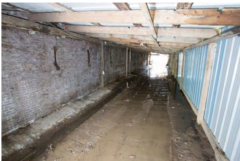
Inferieure aanbouw tegen de achtergevel.
