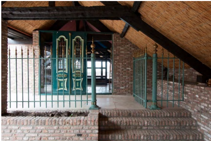
Hergebruikt hekwerk dat vermoedelijk werd toegepast om privé en zakelijk te scheiden.
