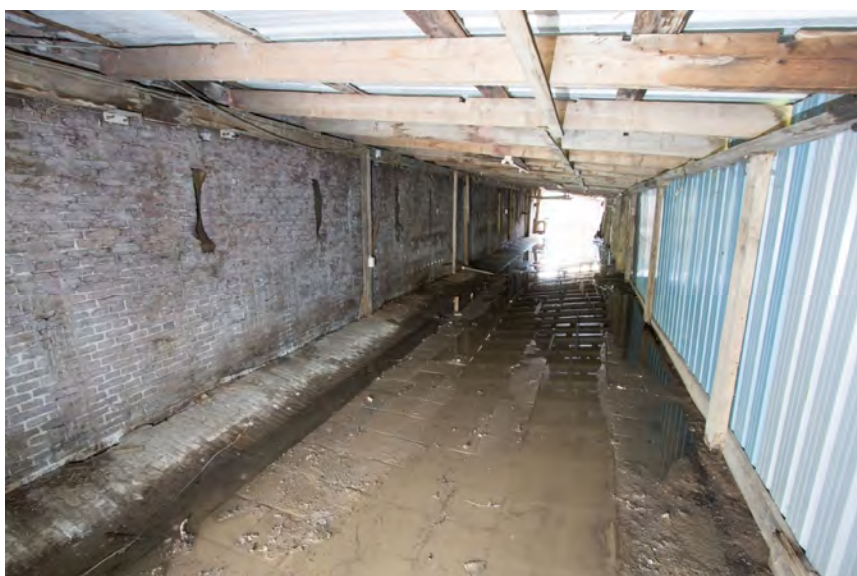
De achtergevel, het deel dat door aanbouw vanaf de wal aan het zicht is onttrokken. Op de opname is het rabat goed te zien.
