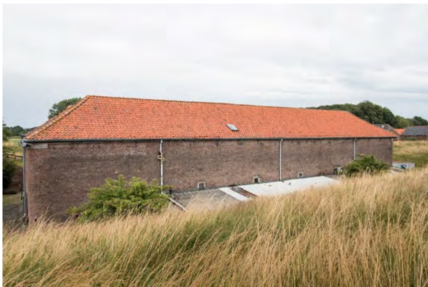
De achtergevel in de huidige toestand.
