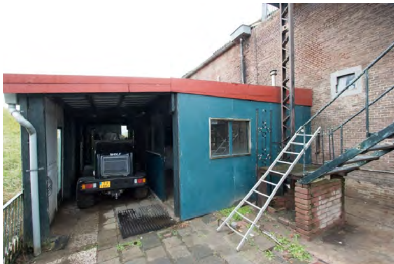
De aanbouw tegen de linker zijgevel van het bomvrije gebouw.
