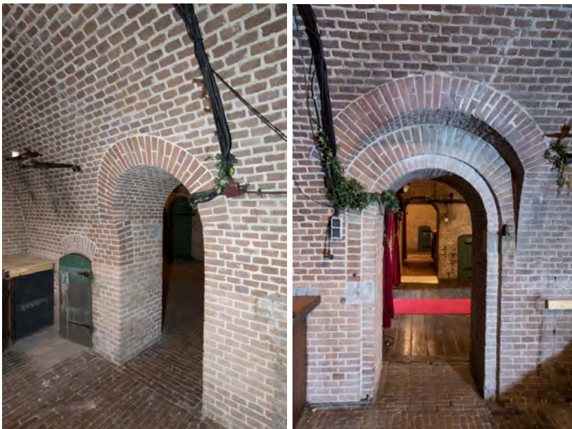
Op de foto links de doorgang naar ruimte 1, met een (verdwenen) naar buiten draaiende deur. Op de foto rechts de doorgang naar de centrale ruimte 5, waar een naar binnendraaiende deur is verdwenen. Beide deuren zijn in een bijgebouwtje in opslag genomen, en zouden dus teruggeplaatst kunnen worden.
