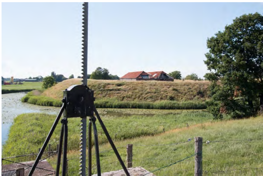
Vermoedelijk als gevolg van verval en erosie is de borstwering met schietopeningen verdwenen, waardoor de relatie tussen verdedigingswerk en de sluis op de voorgrond minder duidelijk is geworden.
