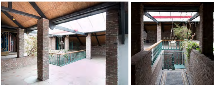
De hal met trapgat onder lichtkap.
