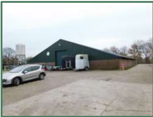
Achterzijde melkveestal met parkeerruimte
