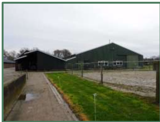
Achterzijde te slopen stal met rijhal
