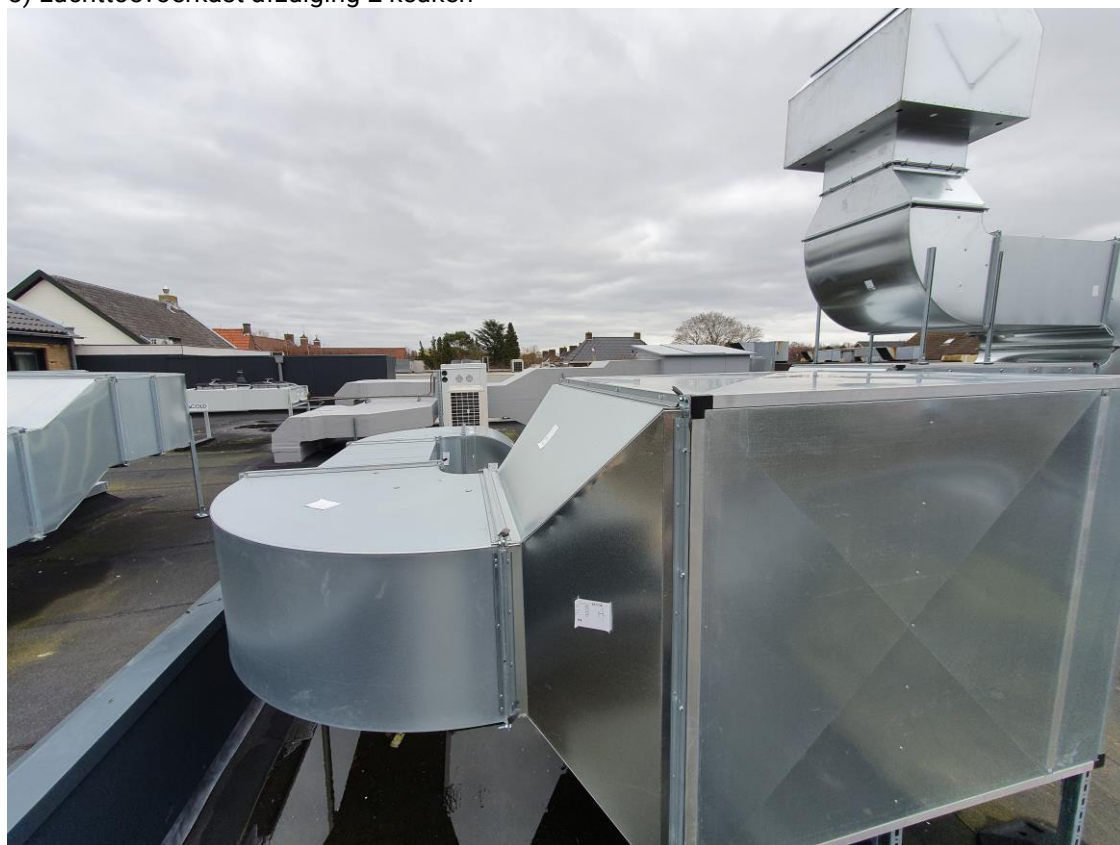
9) luchtafblaaskast afzuiging 2 keuken
