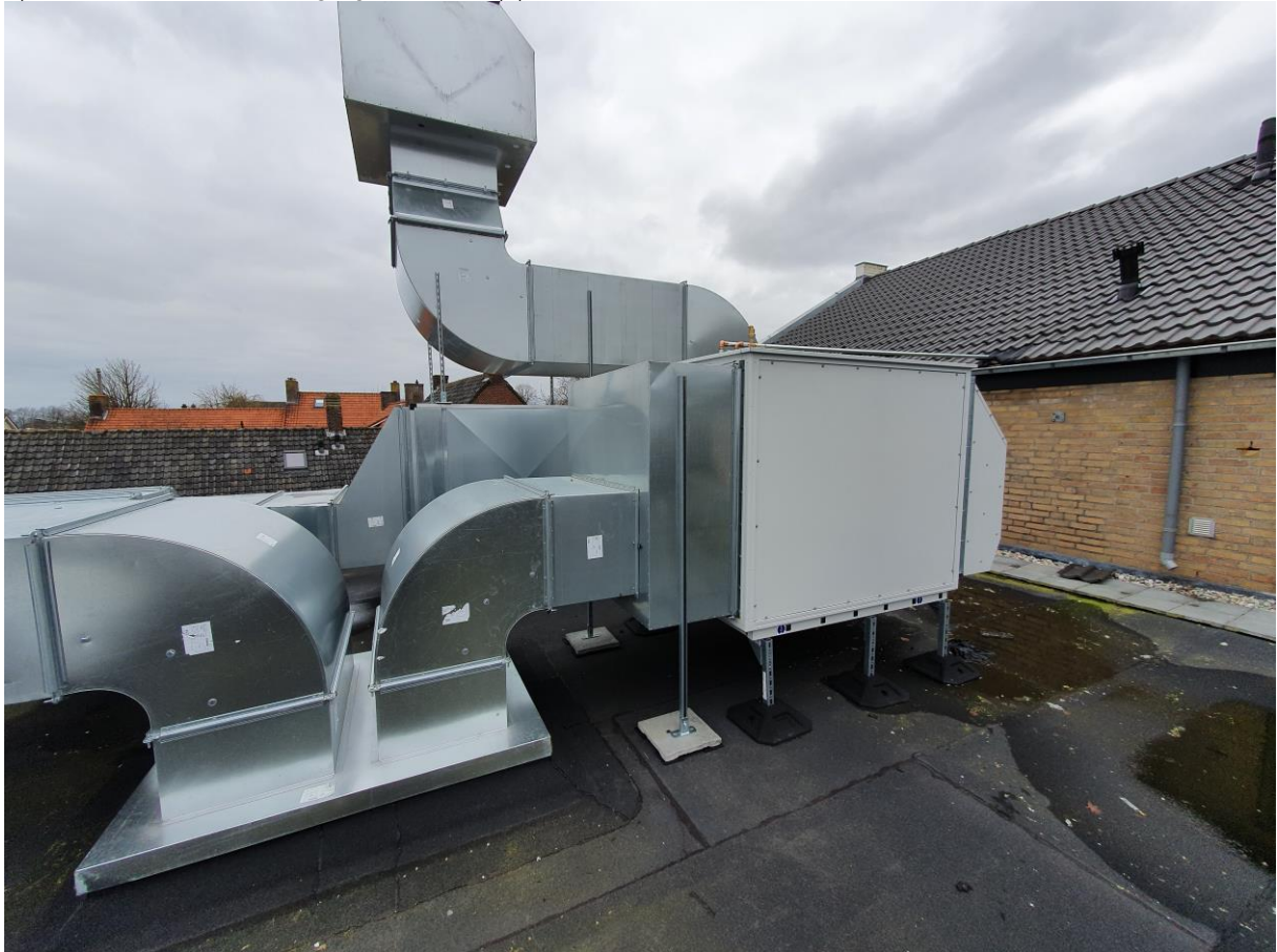
7) luchtafblaaskast afzuiging 1 keuken
