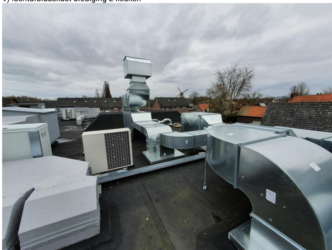
9) luchtafblaaskast afzuiging 2 keuken
