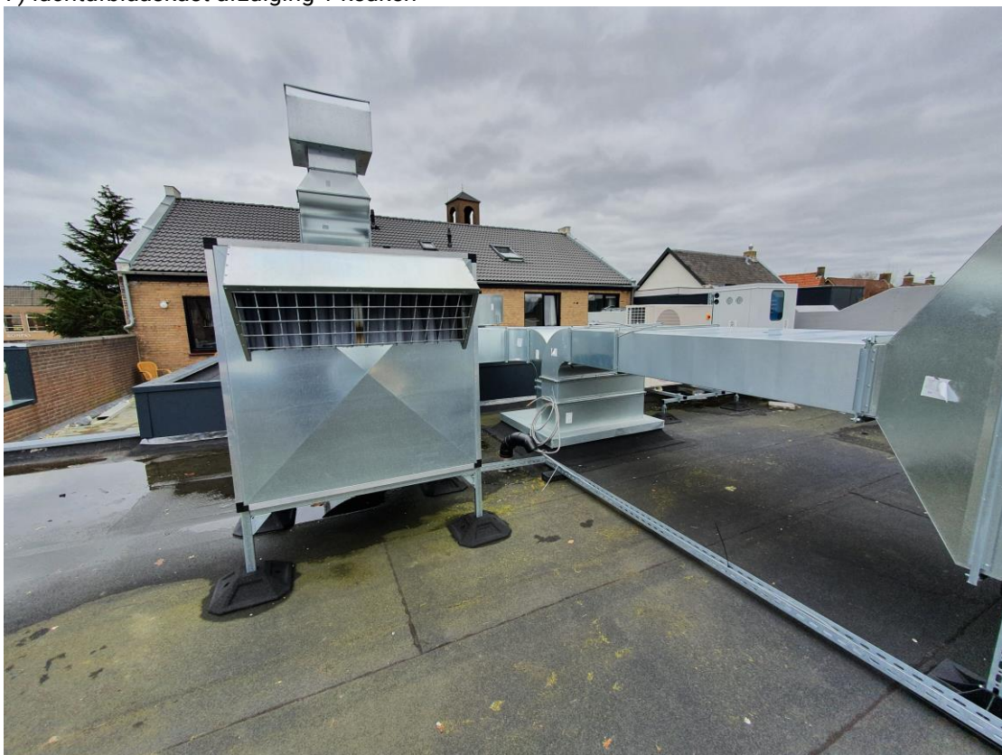
7) luchtafblaaskast afzuiging 1 keuken
